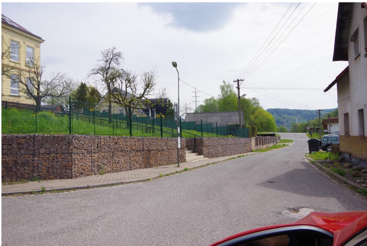
Obr. 43: Pohled na autobusovou zastávku Voletiny, točna (od autobusového obratiště) 49
