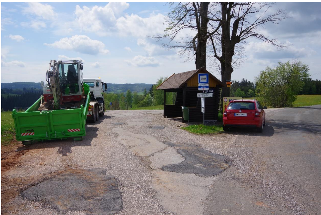
Obr. 35: Pohled na autobusové obratiště Dolce, točna (Pohled od místní části Oblanov) 41
