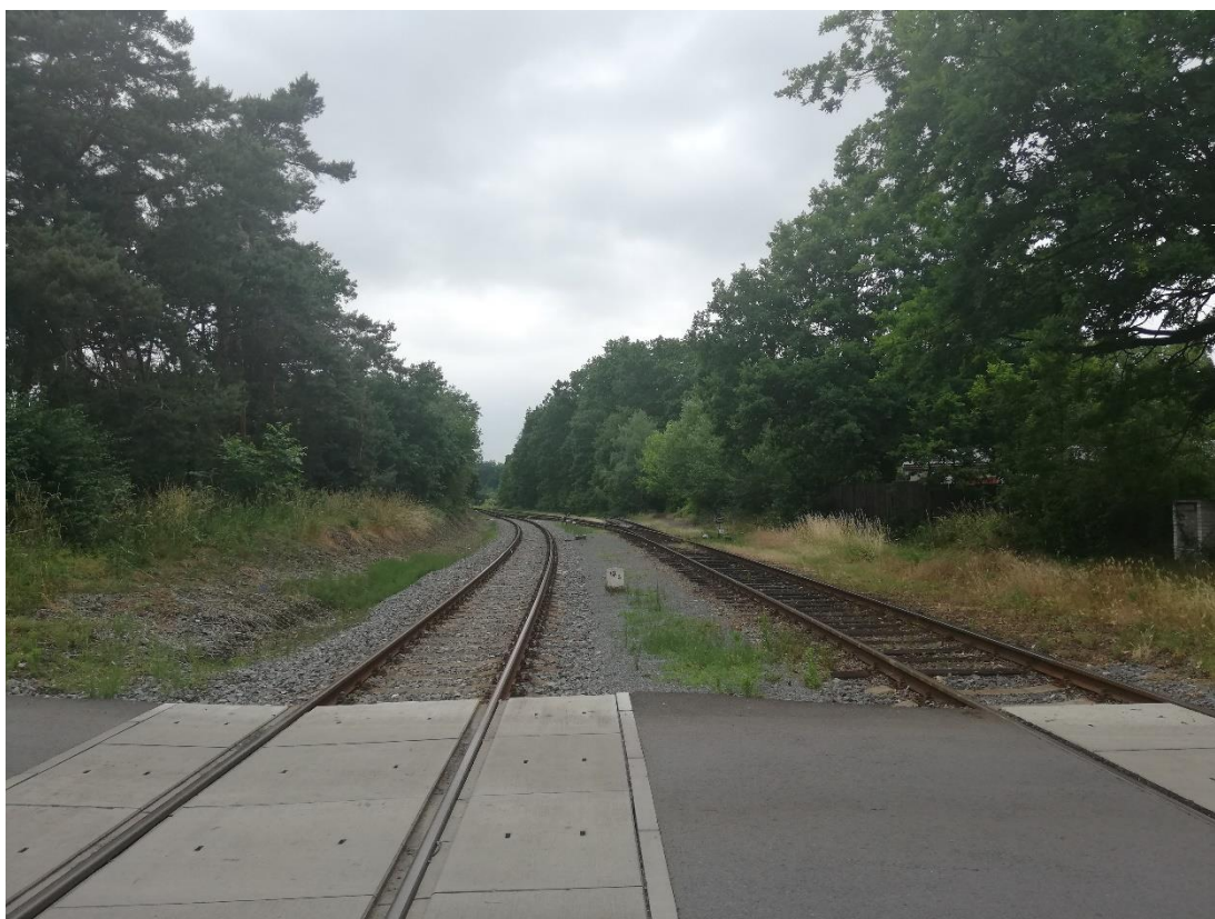
Obrázek 55 – Pohled na úžické zhlaví žst. Neratovice
