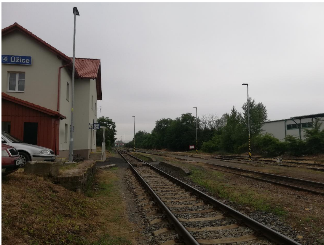
Obrázek 48 – Pohled na úrovňová nástupiště a výpravní budovu v žst. Úžice
