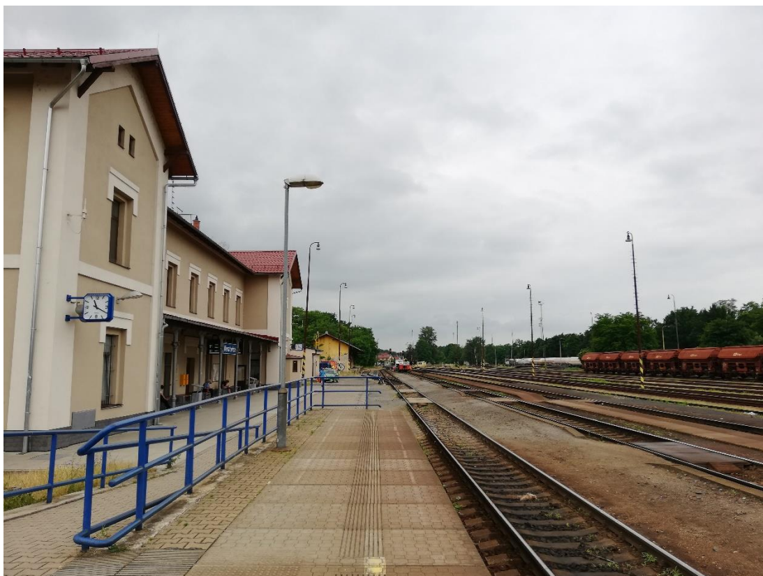
Obrázek 52 – Pohled na kolejiště a výpravní budovu v žst. Neratovice z nástupiště č. I
