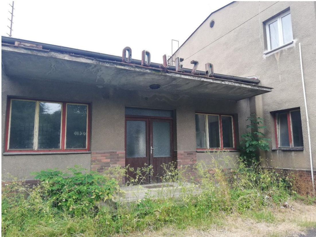
Obrázek 46 – Stávající výpravní budova v žst. Chvatěruby
