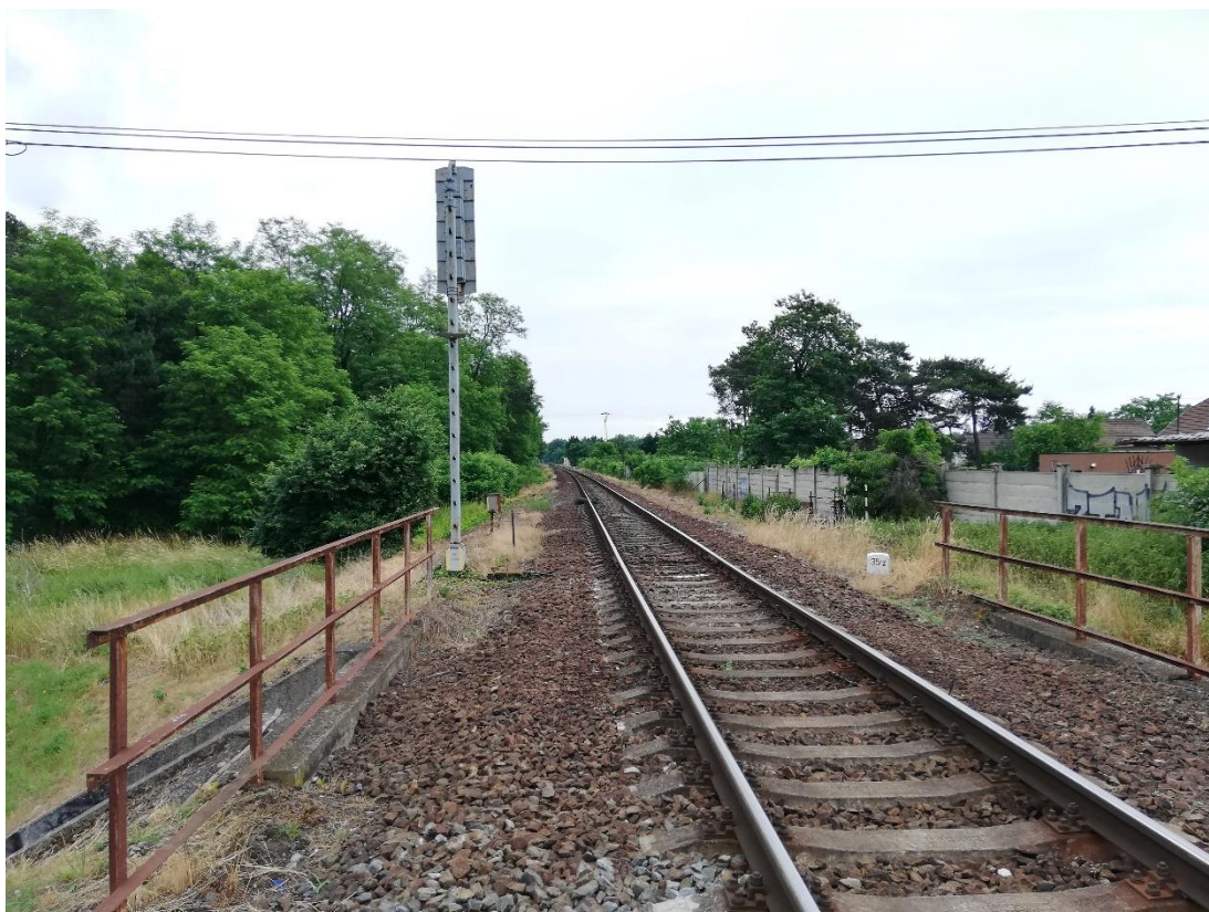
Obrázek 58 – Pohled na železniční trať č. 092 ve směru na Všetaty s vjezdovým návěstidlem do žst. Neratovice a na prostory budoucí zastávky Neratovice-Mlékojedy
