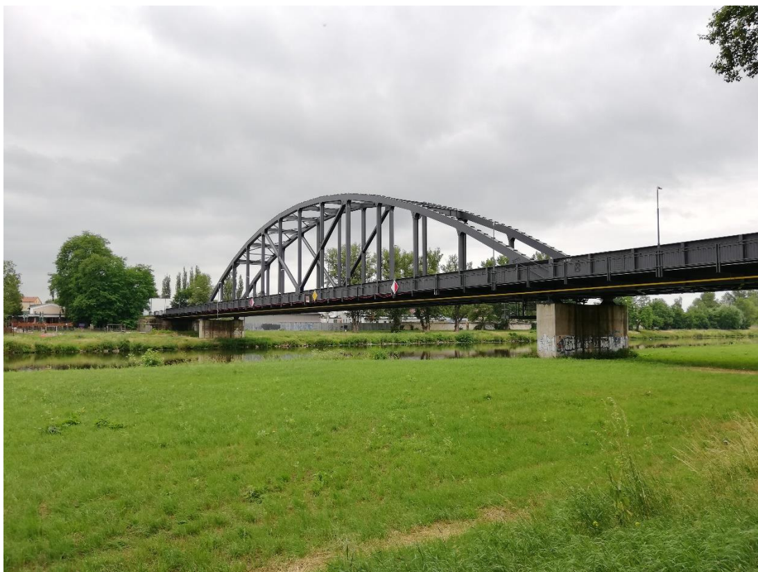
Obrázek 56 – Stávající železniční most přes řeku Labe v Neratovicích
