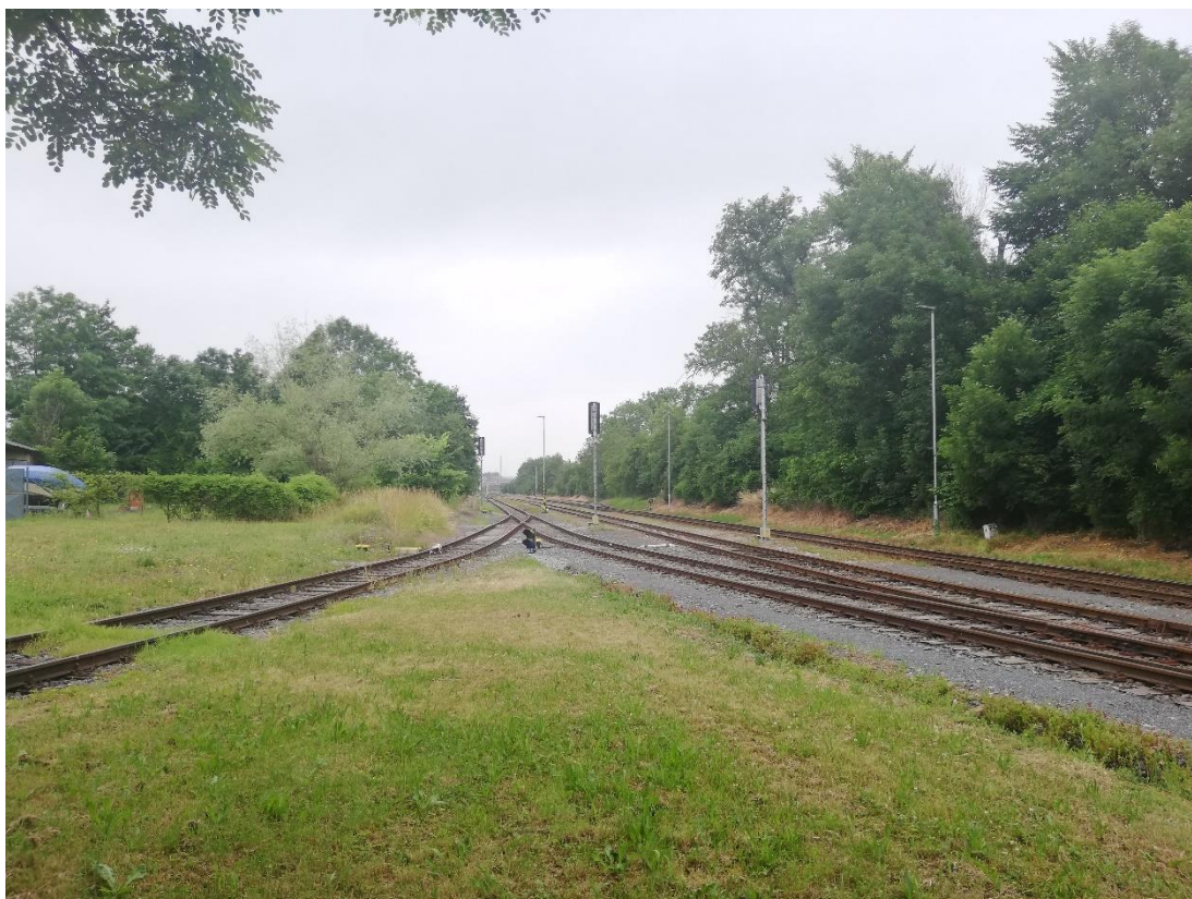
Obrázek 50 – Pohled na neratovické zhlaví žst. Úžice s odjezdovými návěstidly a manipulační kolejí č. 4b
