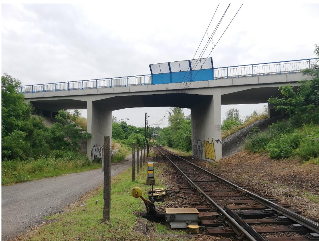
Obrázek 43 – Stávající silniční most, po kterém je vedena silnice III/811 nad železniční trati č. 092 v mezistaničním úseku Kralupy nad Vltavou – Chvatěruby, s přestavňákem výhybky K1 v žst. Chvatěruby
