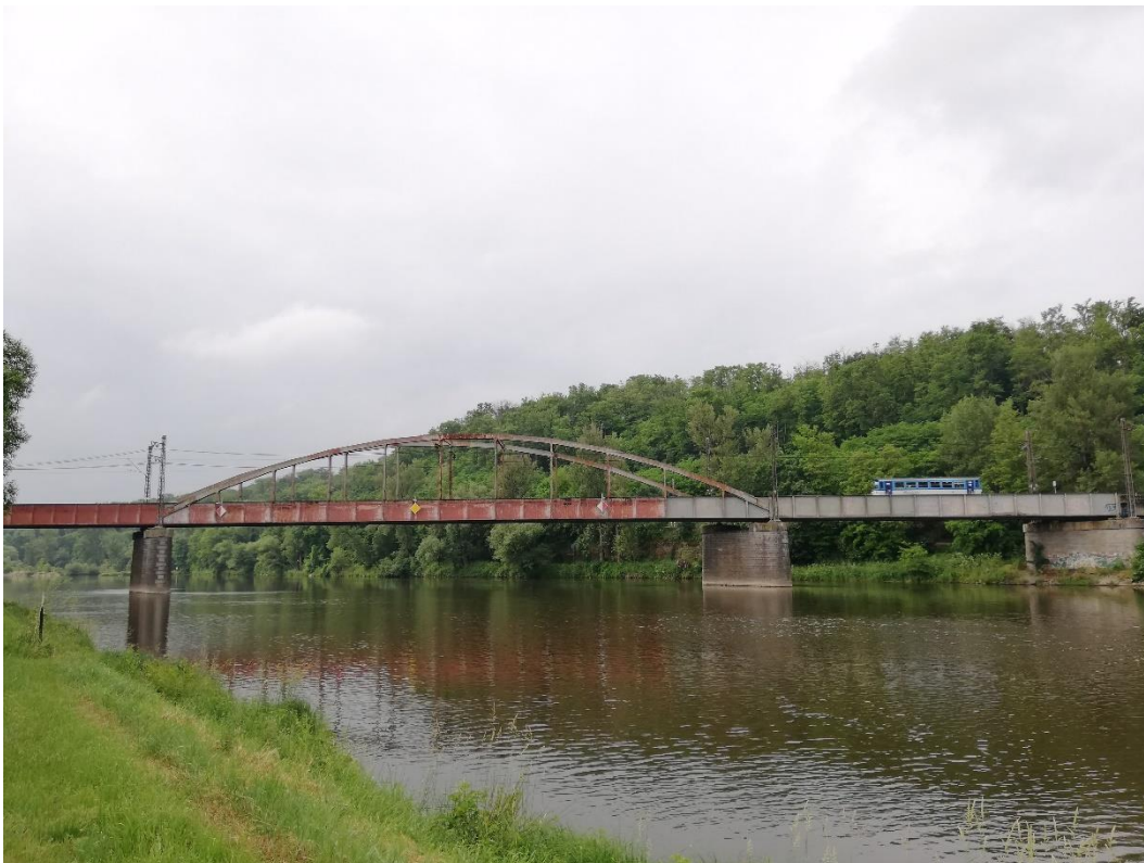
Obrázek 40 – Stávající železniční most přes řeku Vltavu na trati č. 092 s motorovým vozem ř. 809
