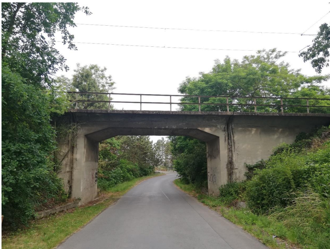
Obrázek 42 – Stávající železniční most přes pozemní komunikaci na trati č. 092 v mezistaničním úseku Kralupy nad Vltavou – Chvatěruby
