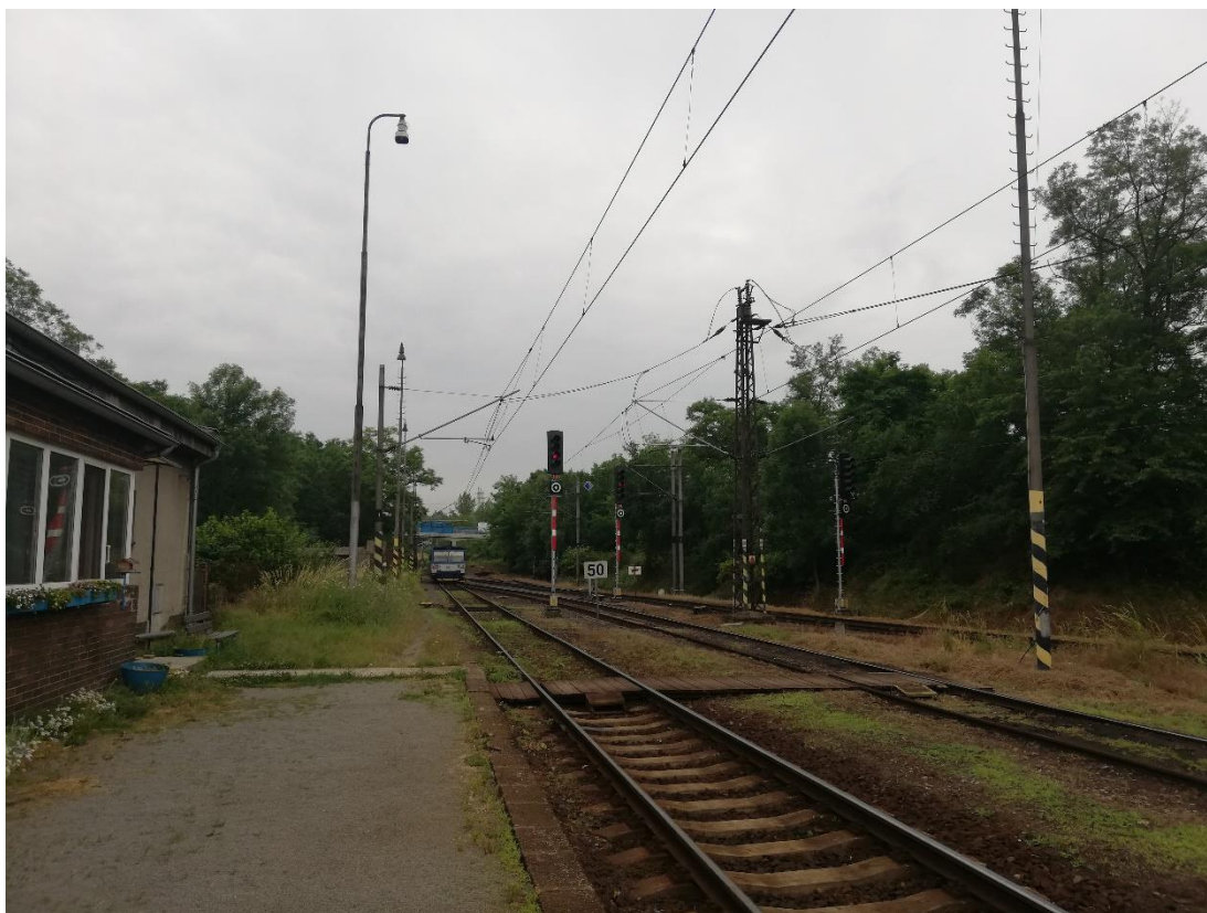
Obrázek 44 – Pohled na odjezdová návěstidla žst. Chvatěruby ve směru na Kralupy nad Vltavou, v pozadí přijíždí osobní vlak z Kralup nad Vltavou, jenž dále pokračuje do Neratovic
