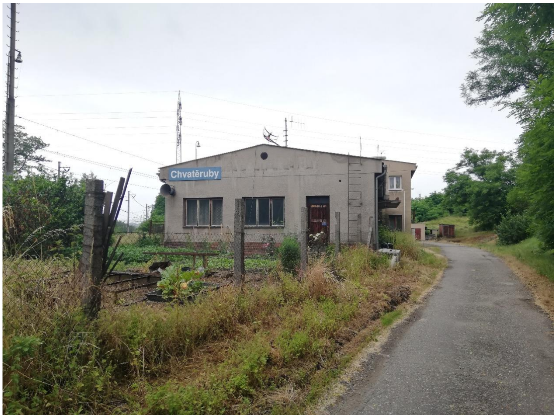
Obrázek 47 – Stávající výpravní budova v žst. Chvatěruby
