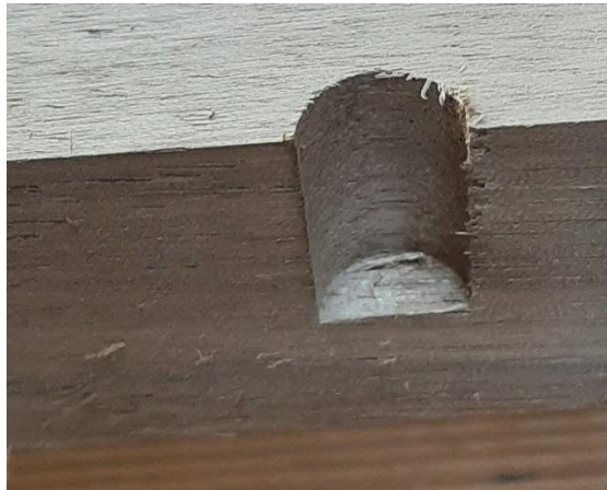
Obrázek 56. Předfrézovaný začátek drážky
