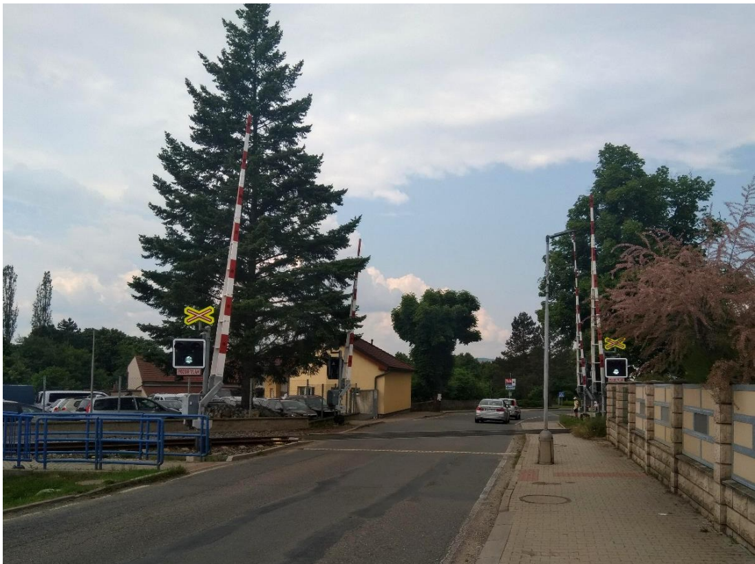
Obrázek 7: Světelné PZZ se čtyřdílnými závorami s aktivní signalizací [autor]
