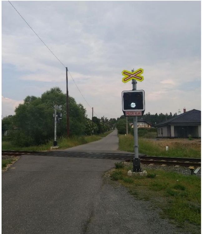
Obrázek 6: Světelné PZZ bez závor s aktivní signalizací [autor]
