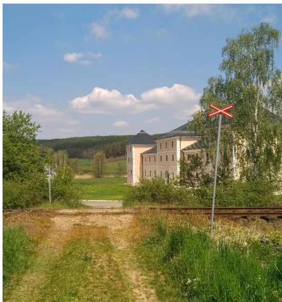
Obrázek 3: Přejezd zabezpečený pouze výstražnými kříži [autor]
