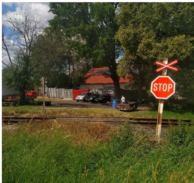
Obrázek 4: Přejezd zabezpečený výstražnými kříži, doplněný dopravním značením P 6 „Stůj, dej přednost v jízdě!“ [autor]
