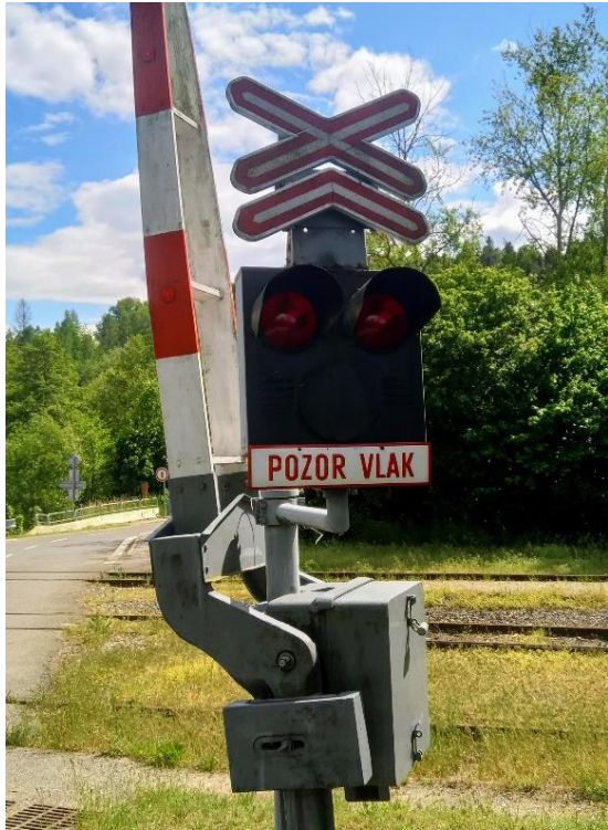
Obrázek 5: Světelné PZZ se závorami bez možnosti aktivní signalizace [autor]
