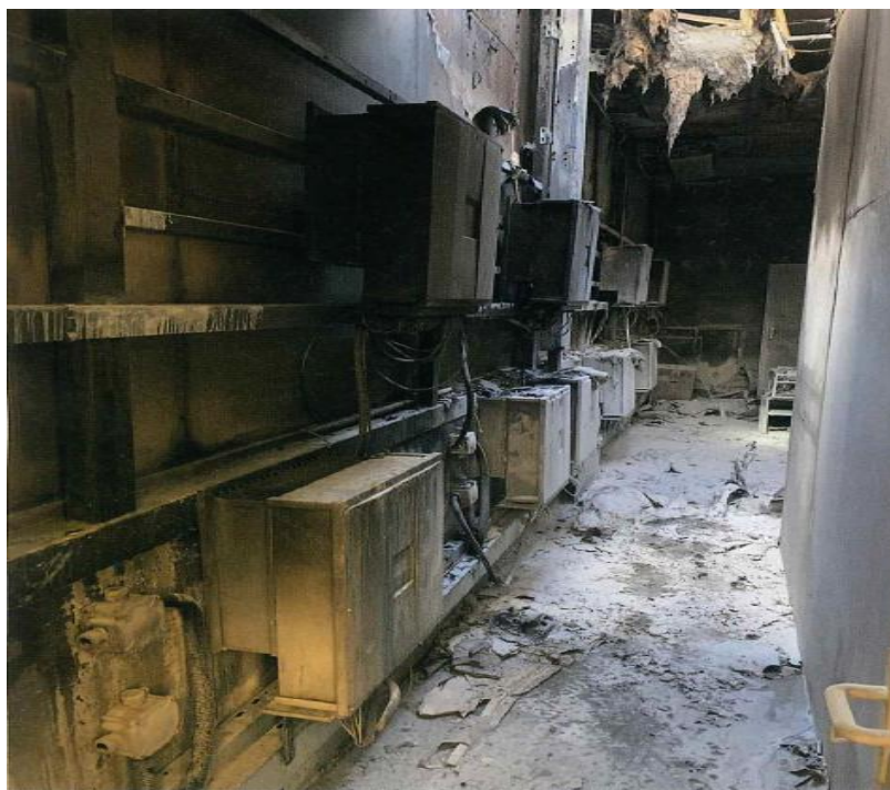
Obrázek 15 Technologická místnost po požáru
