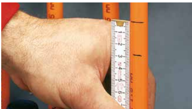
6a. Označení hloubky zasunutí 27 mm
