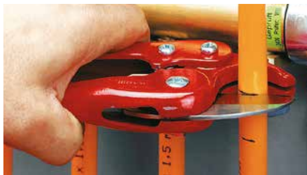
6b. Úprava délky trubky na horní značce
