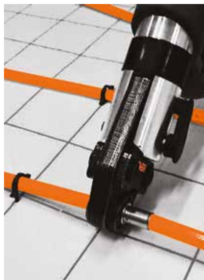
3. Spojení trubek lisovaným spojem
