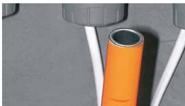
6d. Kontrola usazení opěrného pouzdra
