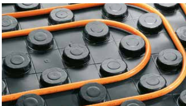
5a. Minimální poloměr oblouku: okolo 3 výstupků při ohybu o 180°, příp. okolo 2 výstupků při ohybu o 90°.
