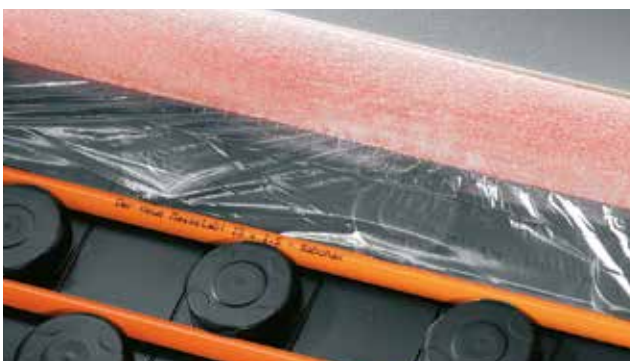
5d. Přichycení fólie dilatačního pásu (pouze u tekutého potěru)
