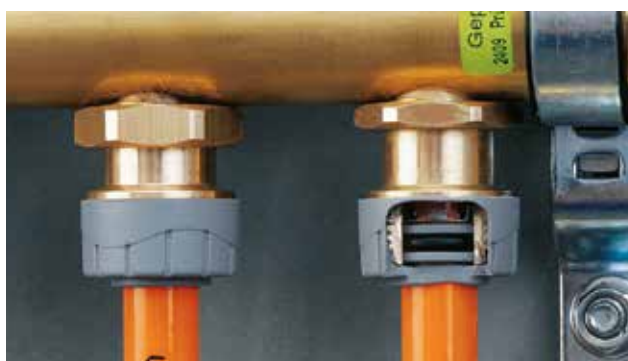
7. Řez hotovým násuvným spojem
