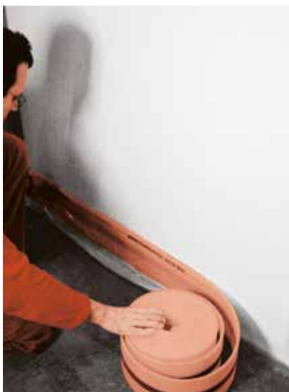
1. Položení dilatačních pásů
