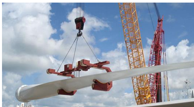
Obr. 11: Zdvihání lopatky větrné elektrárny [8]
