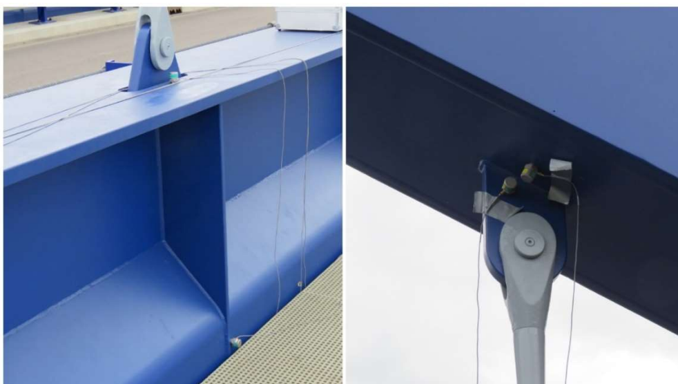
Obrázek 36: Snímače zrychlení umístěné na levém obrázku do bodů RefAz121 (na horní pásnici) a RefAy121 (na výztuže stojiny), na pravém obrázku do bodů Azobl181 (na dolní pásnici oblouku) a Ayobl181 (na výztuže připojující k oblouku čep závěsu).
