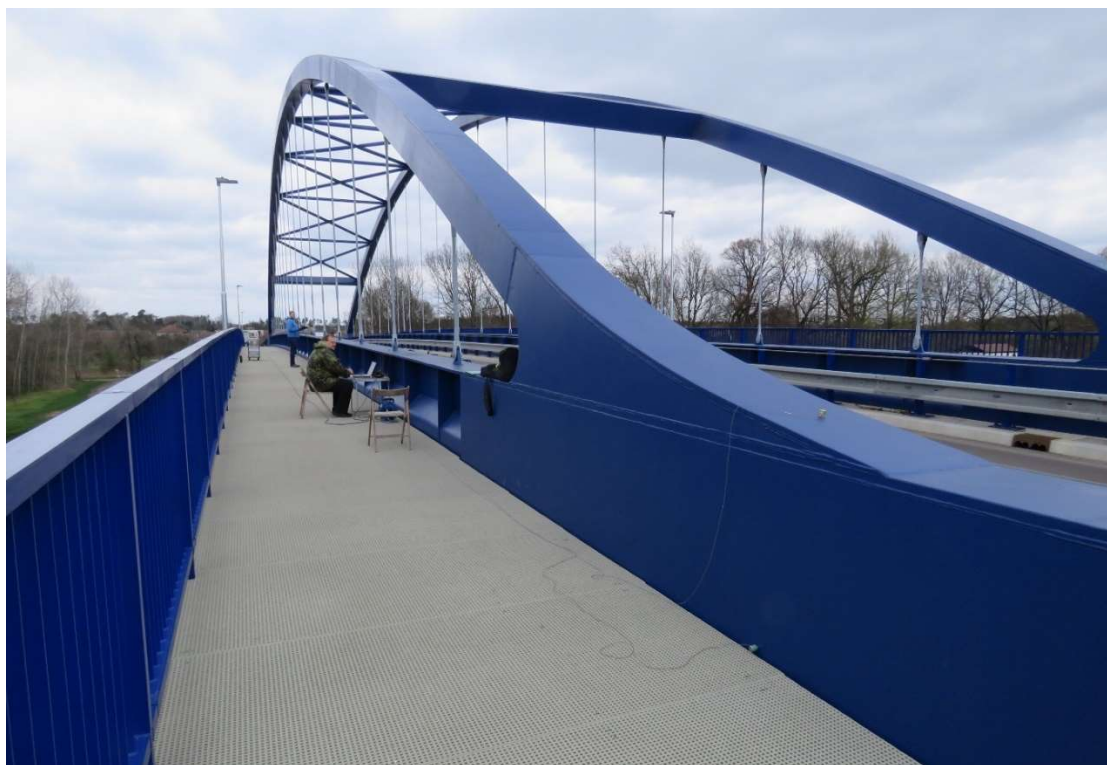
Obrázek 47: Detail připojení oblouku k hlavnímu nosníku na mostě.
