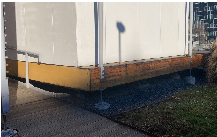
Obrázek 8: Detail objektu - pohled na základy stavby
