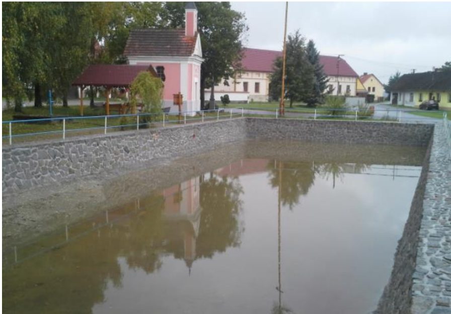
Obrázek č. 3: Požární nádrž v Kašíně hoře [7].
