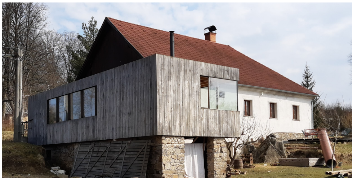
Obr. 2: Pohled na přístavbu kanceláře (současný stav)
