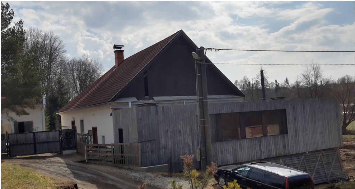
Obr. 4: Pohled na objekt (současný stav)
