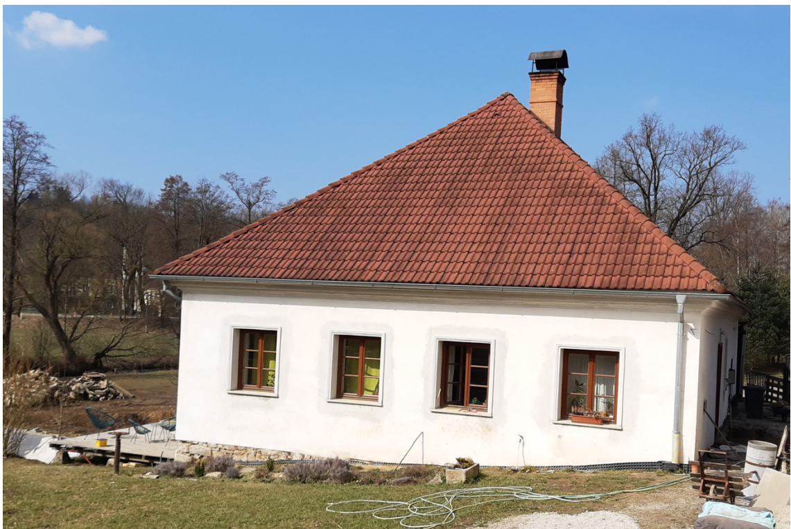
Obr. 3: Pohled na jihovýchodní stranu objektu (současný stav)
