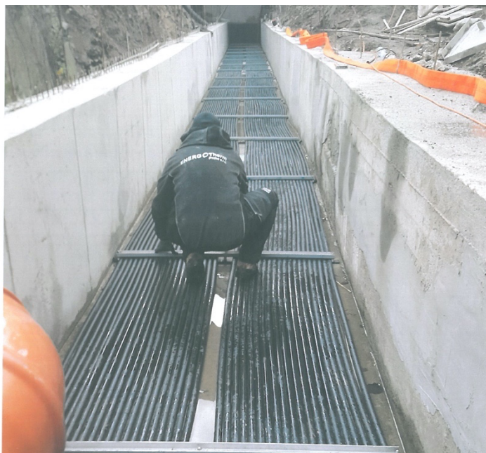
Obr. 10: Ukázka provedení vodního kolektoru v náhonu, zdroj IVT
