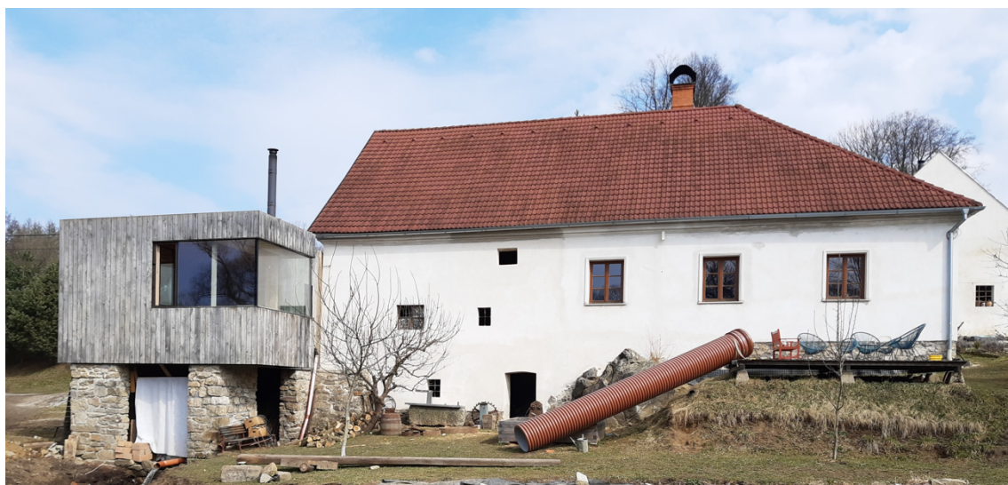
Obr. 1: Pohled na jihozápadní stranu objektu (současný stav)
