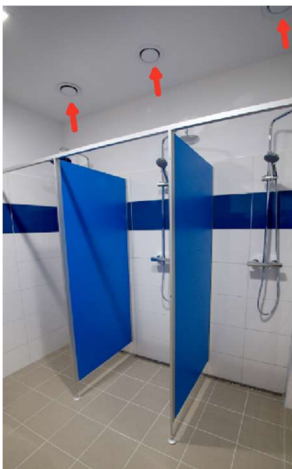
4.7 - Odvodní talířové ventily v hygienickém zázemí [18]
