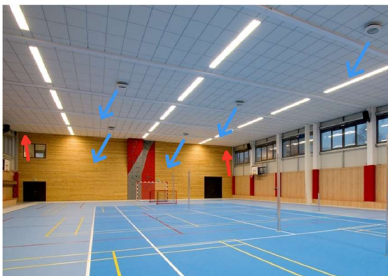
4.6 - Schéma přívodu a odvodu vzduchu v prostoru haly [18]
