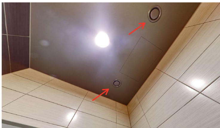
4.20 - Odvodní talířové ventily z VIP boxu [24]
