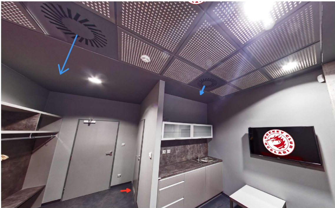
4.19 - Přívod vzduchu do prostoru VIP boxu [24]
