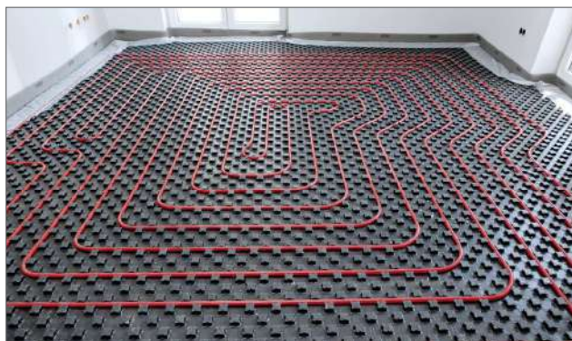
Obr. 3-11 Systémová deska Varionova s kročejovou izolací 30-2
