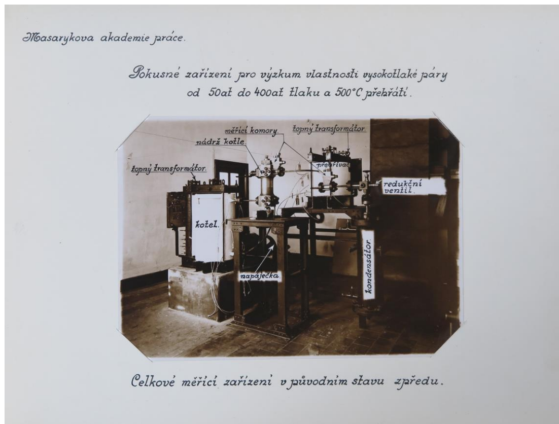
Obr. 62. Dobová fotografie pokusného zařízení pro výzkum vlastností vysokotlaké páry.
