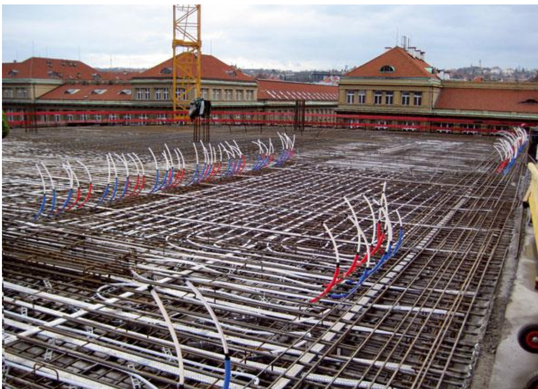
Obr. č. 9 Rozvody potrubí mezi armaturami nezalitě stropní desky budovy NTK 15
