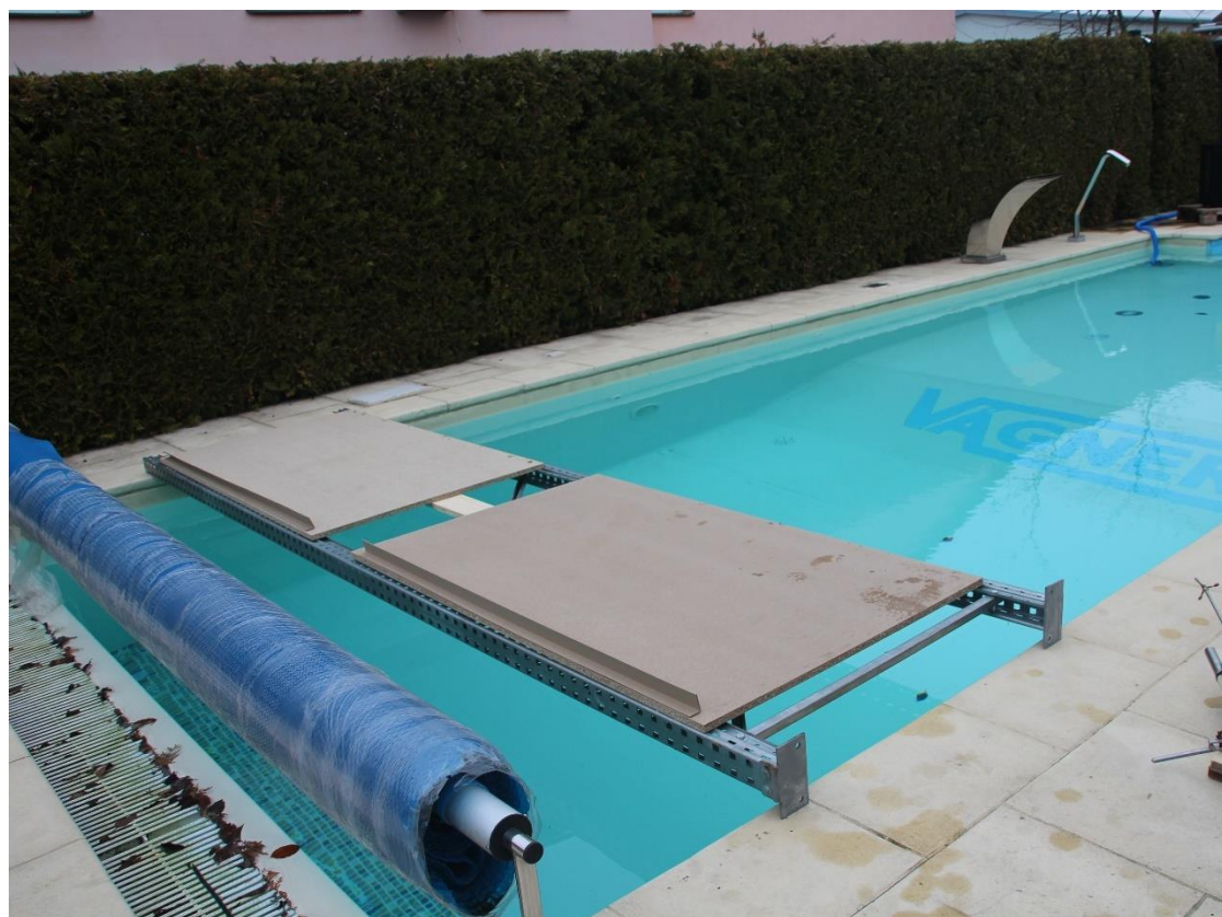
Obrázek 28: Pomocná přehradová konstrukce s OSB desky
