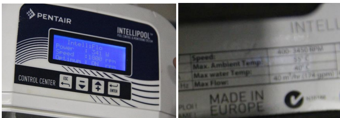
Obrázek 51: Nastavení řídicí jednotky a parametry čerpadla
