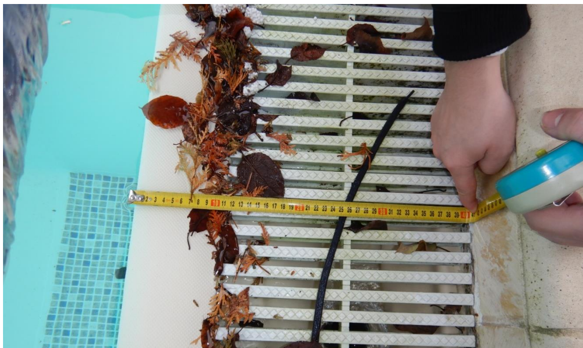
Obrázek 14: Přelivný žlab chráněný plastovým roštem.
