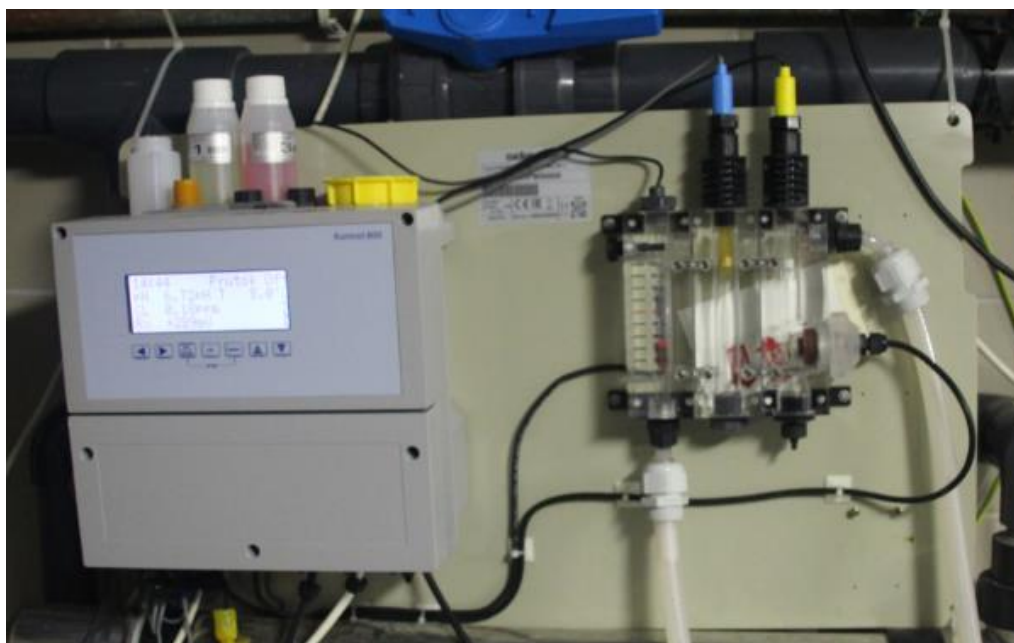
Obrázek 21: Dávkovací čidla a řídicí jednotka.
