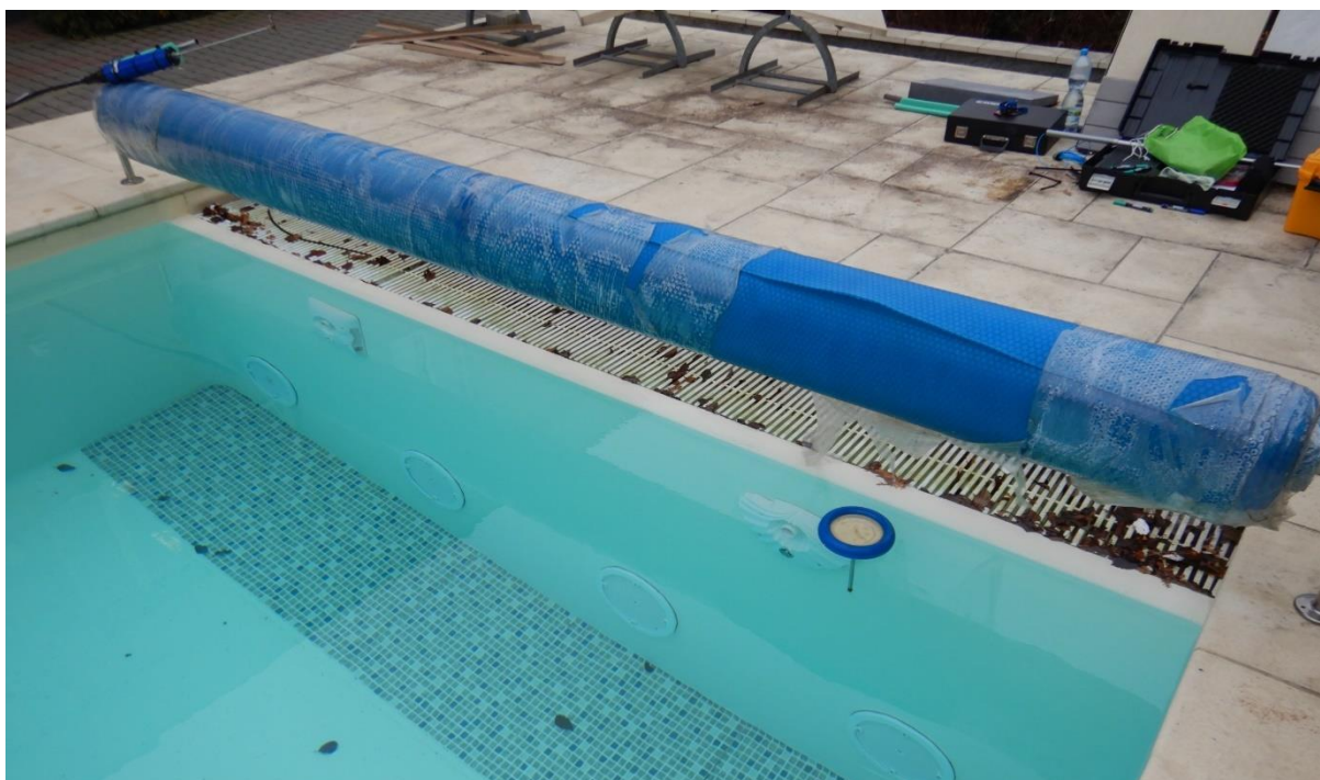
Obrázek 15: Přelivný žlab a stočená krycí plachta.
