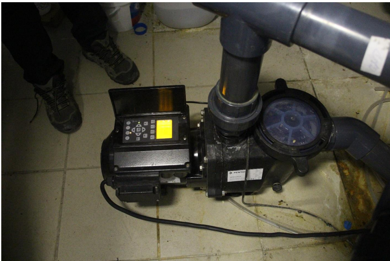
Obr. 12 : Detailní pohled na recirkulační čerpadlo při měření rychlostí na bazénu ve společnosti Vágnerpool.
