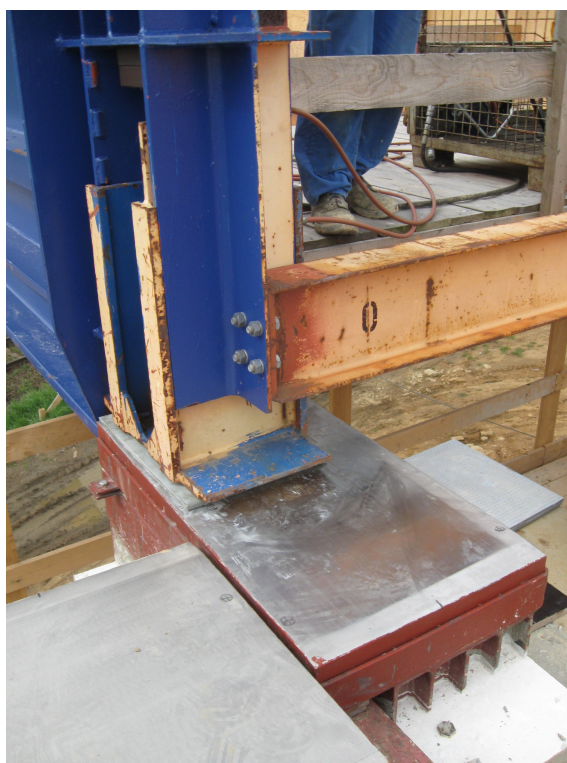
Obr. 26. Zvedací lisy na začátku výsuvného nosu [16]
