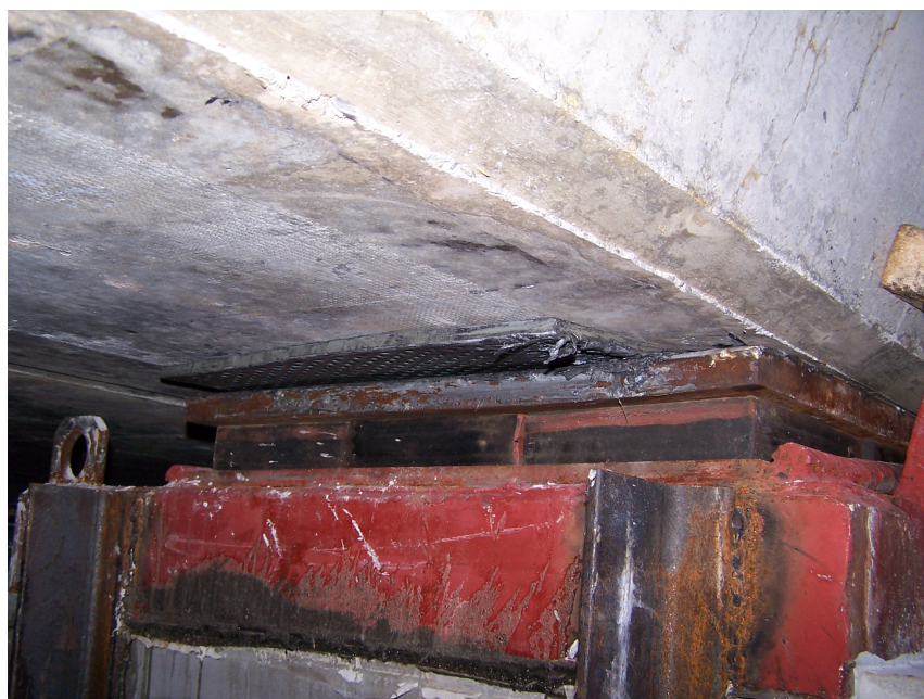
Obr. 17. Kluzné ložisko [16]
