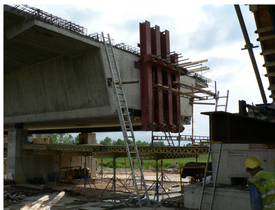
b) Ocelová konstrukce pro zakotvení tažných lan [16]
