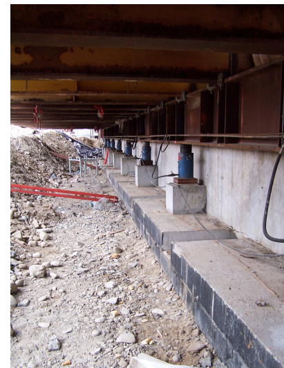
b) Ocelové nosníky podpírající segment na výrobním dvoře [16]
