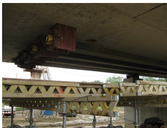
b) Ocelová konstrukce pro zakotvení tažných lan [16]
