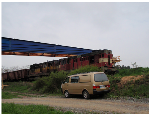
Obr. 6. Zachování provozu pod vysouvanou nosnou konstrukcí [16]
