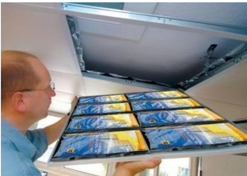
Obr. 32 Aplikácia PCM materiálov do stavebných konštrukcií [18]
