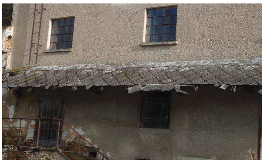
Obr. 17 Pohled na dřevěnou stříšku
