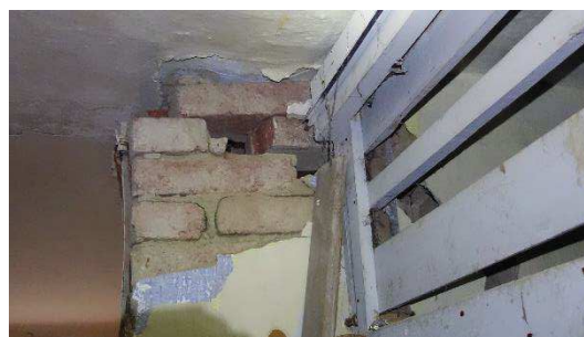
Obr. 65 Posunutá zeď
