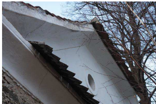
Obr. 88 Došky zakrývající římsku
