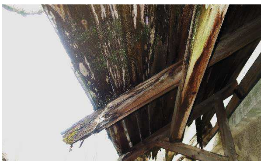
Obr. 53 Degradovaná stříška
