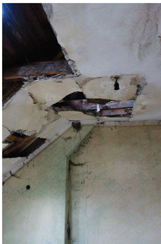
Obr. 80 Odpadávající omítka
