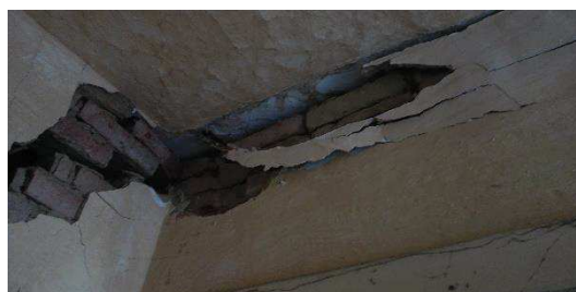
Obr. 66 Posunutá zeď
