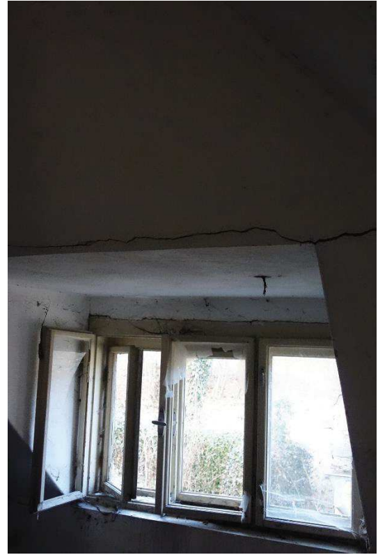
Obr. 82 Špaletová okna
