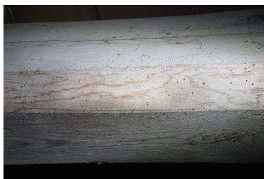
Obr. 43 Napadení červotočem
