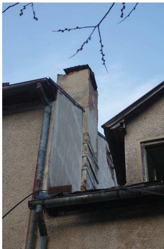
Obr. 59 Komín vystupující nad střechu
