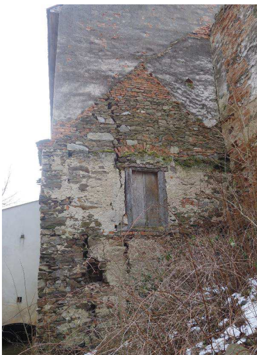
Obr. 35 Svislá trhлина od sesuvu
