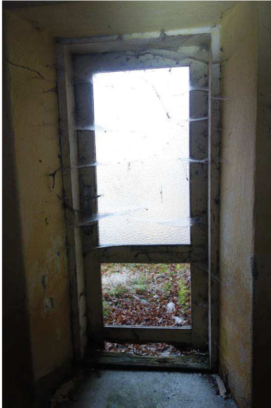
Obr. 81 Dveře na terasu
