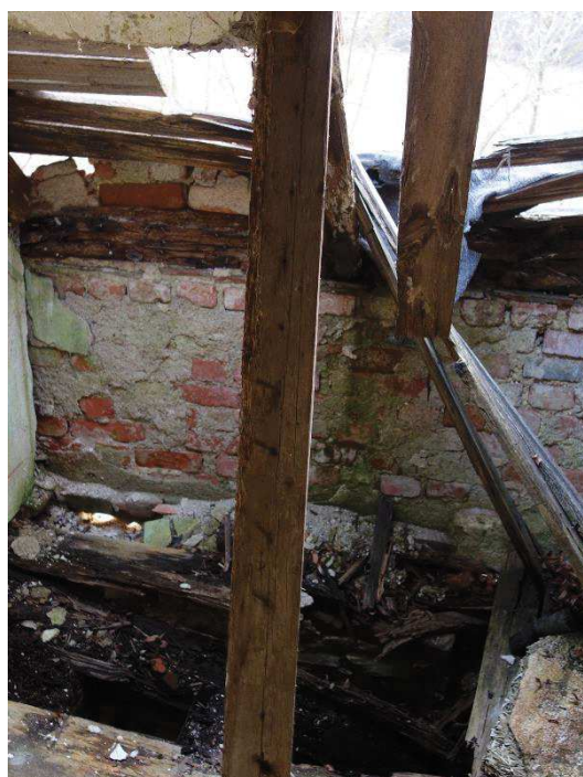
Obr. 70 Porušená podezdívka
