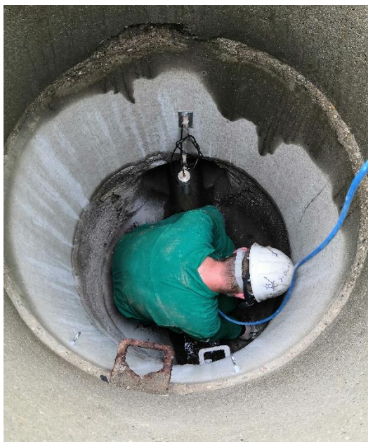
Obr. 66: Instalace přístrojů do měrného profilu Bukovno
