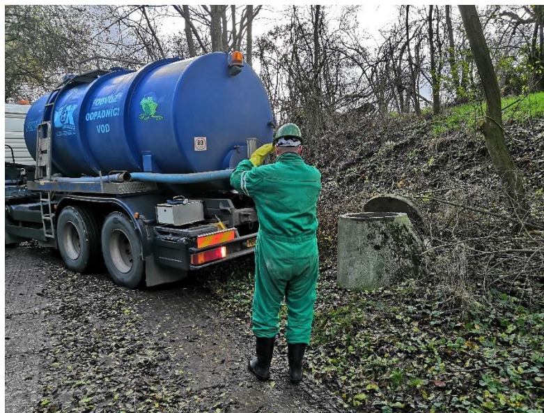
Obr. 69: Příjezd cisterny k šachtě výše proti proudu, tedy nad profilem, kde probíhala injektáž stopovače
