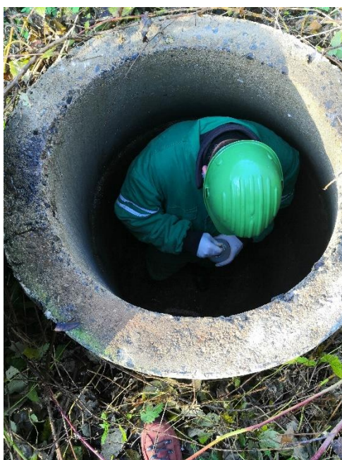
Obr. 67: Vlévání roztoku do kanalizace při kalibraci měrných profilů pomocí stopovače
