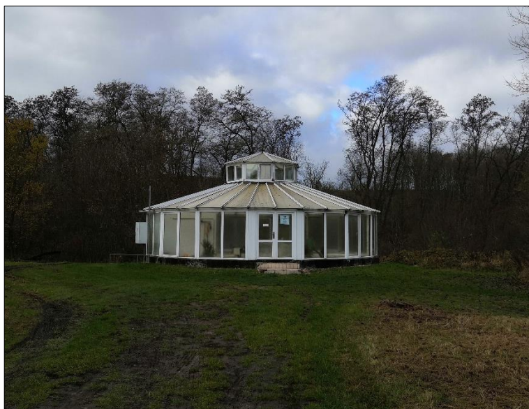
Obr. 23: Biologická ČOV v Močidlech, Bukovno
