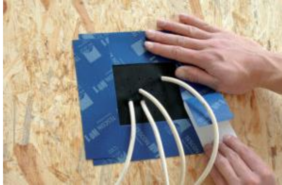
Obr.16b: příklad správného utěsnění prostupu manžetou [13]
