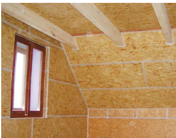
Obr.15a: příklad správného utěsnění spojů a prostupů střechy [10]
