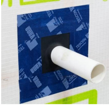
Obr.16a: příklad správného utěsnění prostupu manžetou [13]
