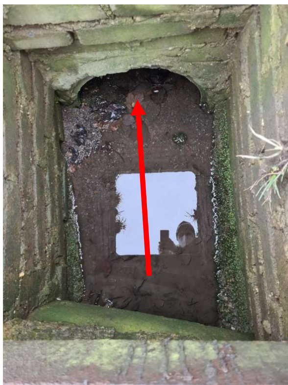
Obr. 13: Druhá šachta ve směru toku v místě křížení Šestajovického potoka s ulicí Šlechtitelskou [65]
