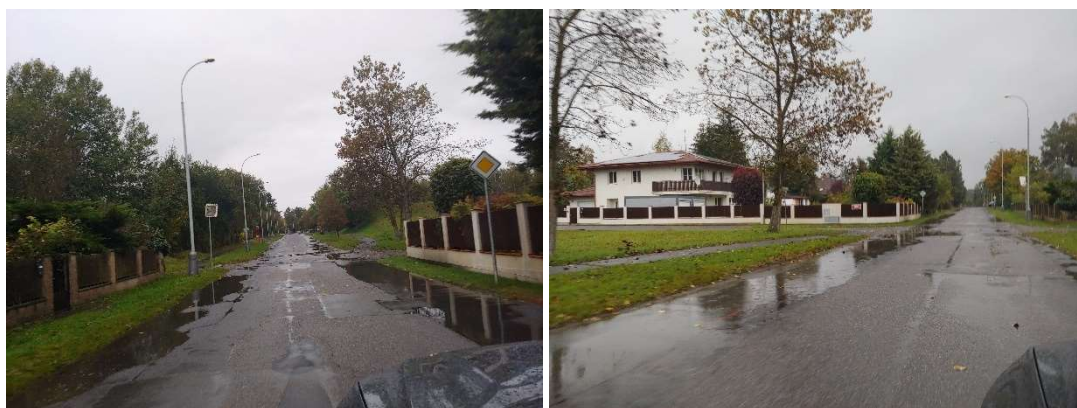
Obr. 15: Kumulace povrchového odtoku na rozhraní komunikace a zeleného pásu (úsek ulice Šlechtitelské v oblasti Přímského náměstí) [65]
