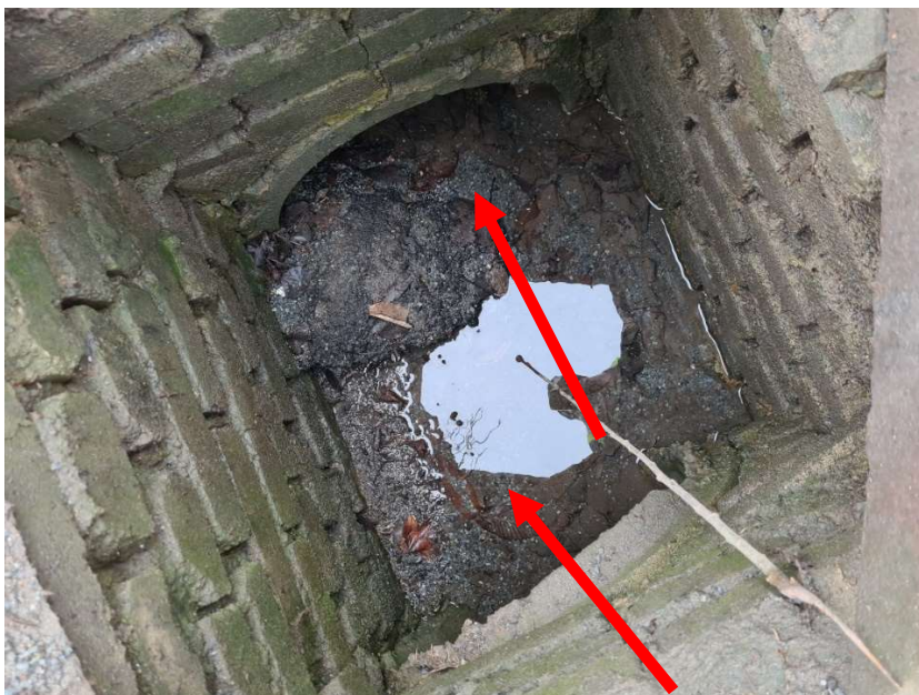
Obr. 12: První šachta ve směru toku v místě křížení Šestajovického potoka s ulicí Šlechtitelskou [65]
