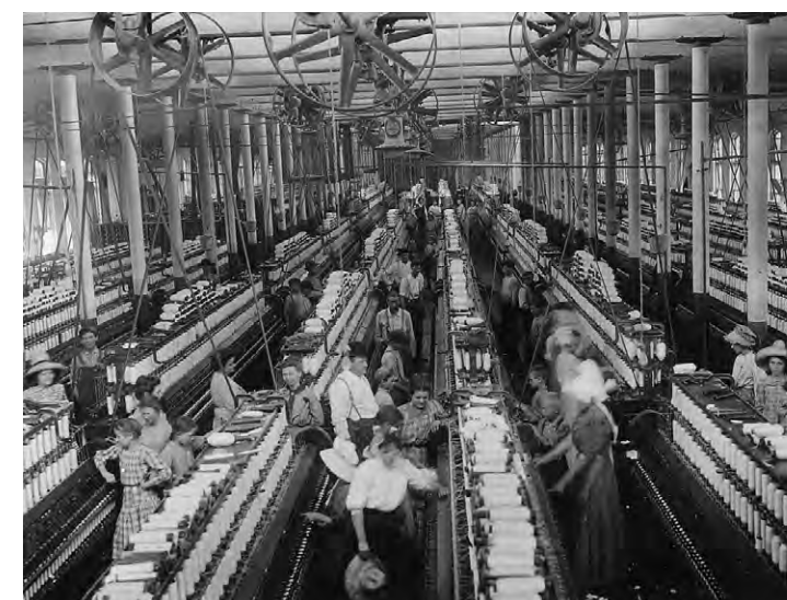
Subtílne nosná konštrukcia a veľké rozpony Magnolia Mill, 1911.
