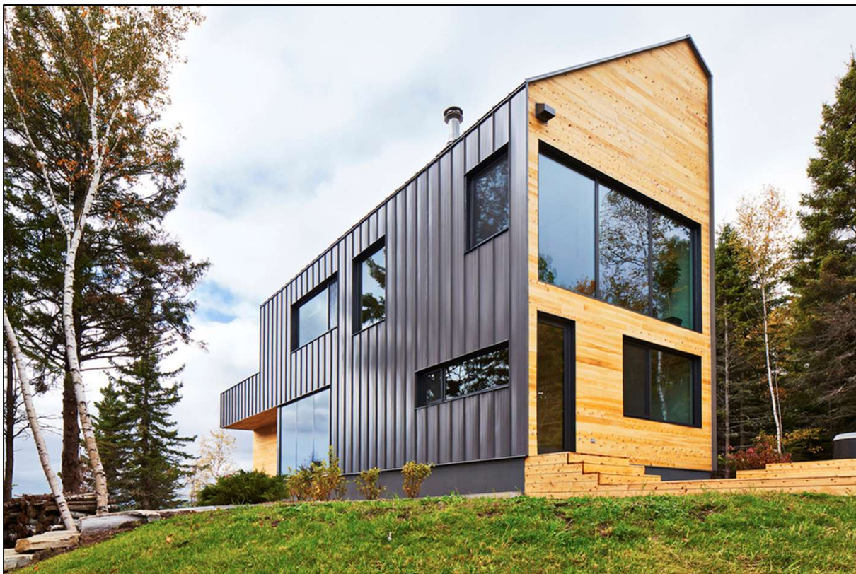
Obr. 9: Fotografie výchozího objektu 2
