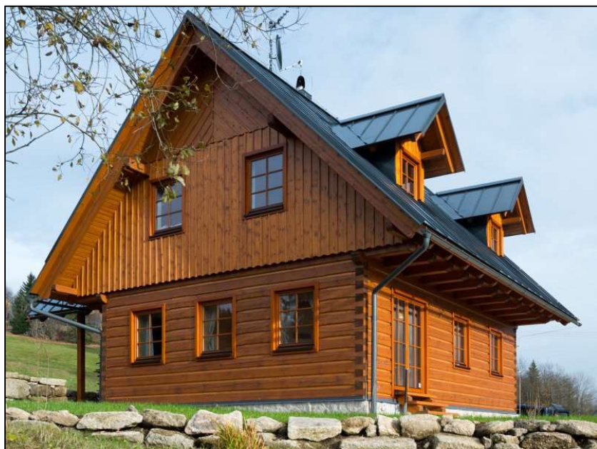
Obr. 16: Příklad roubené dřevostavby
