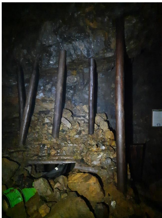
Obr. 20 - dřevěné podpěry dolu
