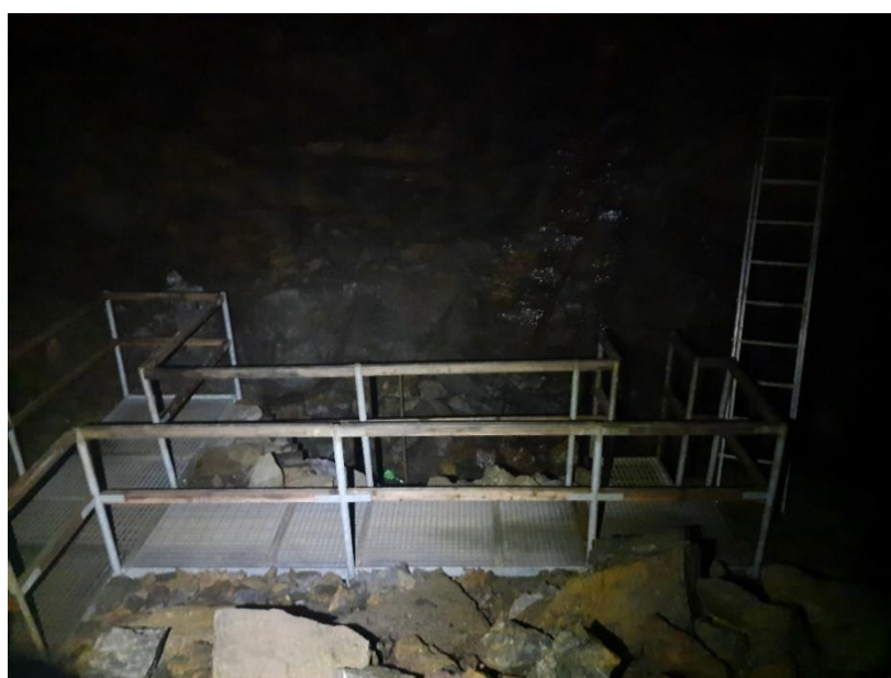
Obr. 21 - vestavěný bezpečný přístup pro návštěvníky
