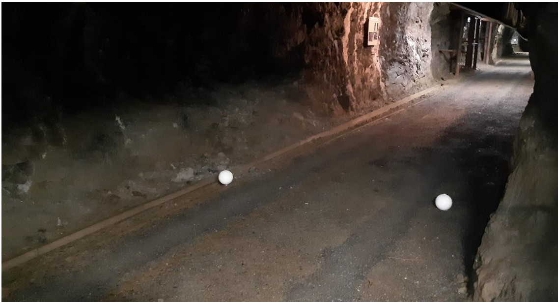
Obr. 12 Guľové terče umiestnené na počve štôlni
