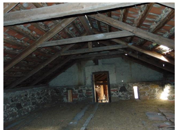
Obr. 25 Hambalková soustava s vrcholovou vaznicí
