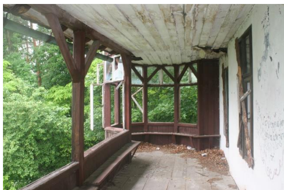
Obr. 43 Pohled do pavlače
