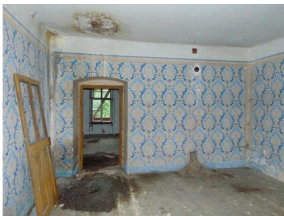
Obr. 45 Důsledek zatékání střechy - malovaná síň
