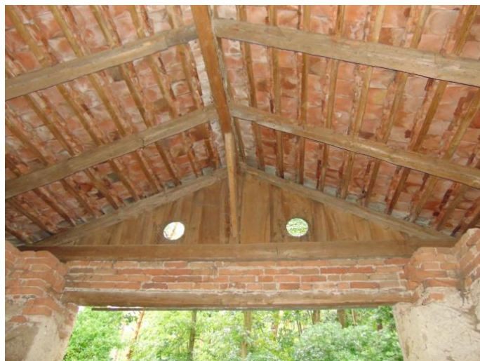
Obr. 18 Přistavěná stodola – pohled na zastřešení
