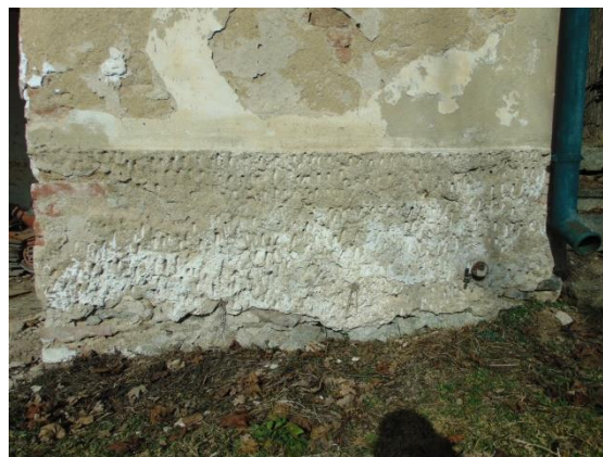
Obr. 38 Základy z lomového kamene
