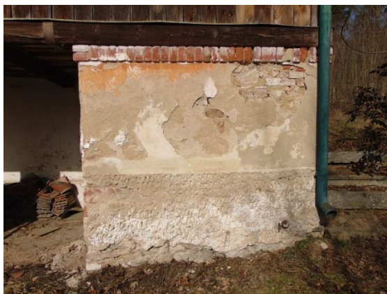
Obr. 37 Základy z lomového kamene
