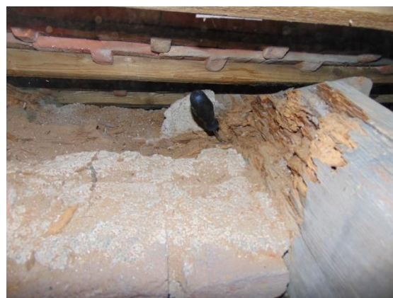
Obr. 50 Destrukce dřeva vlivem celulózovorních hub
