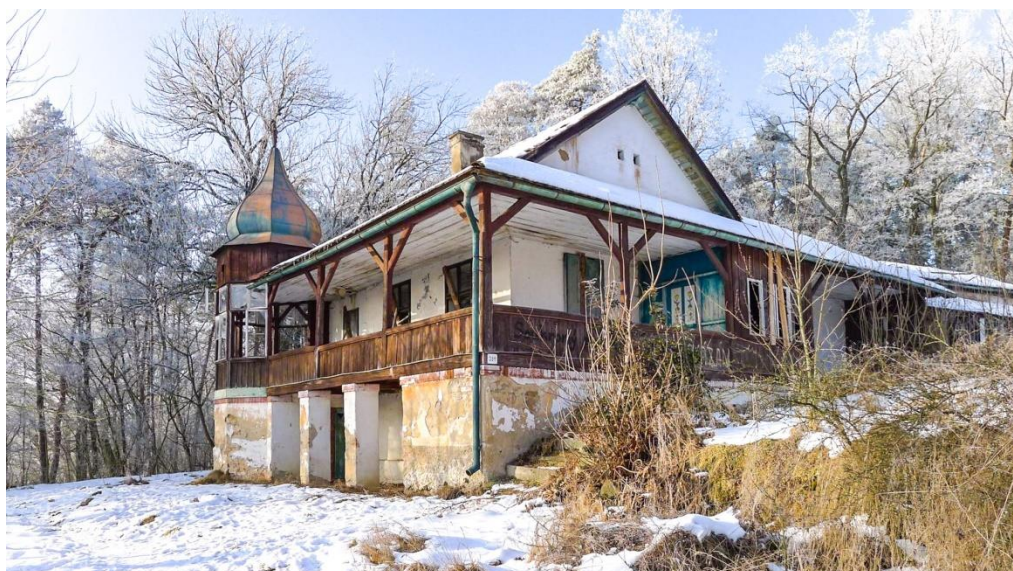
Obr. 4 Jihovýchodní pohled na objekt [4]
