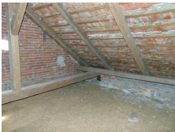
Obr. 21 Konstrukce krovu nad hlavní místností
