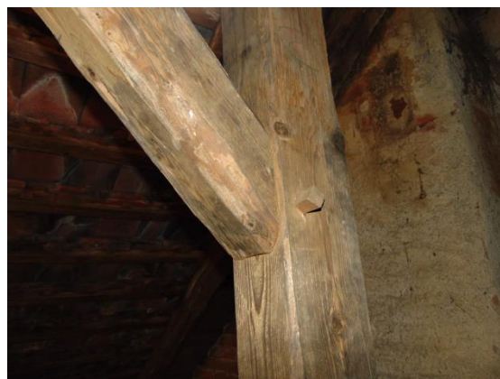
Obr. 22 Detail tesařského spoje sloupek-pásek
