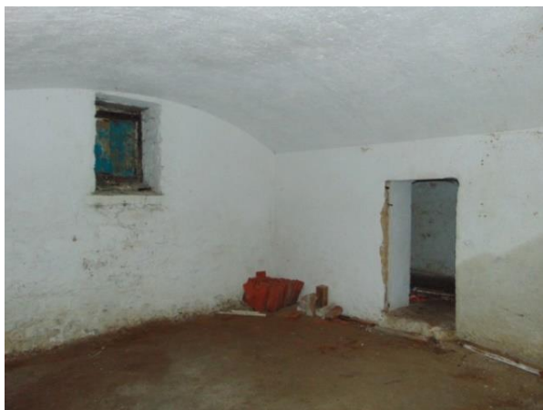
Obr. 11 Sklep se zaklenutou klenbou
