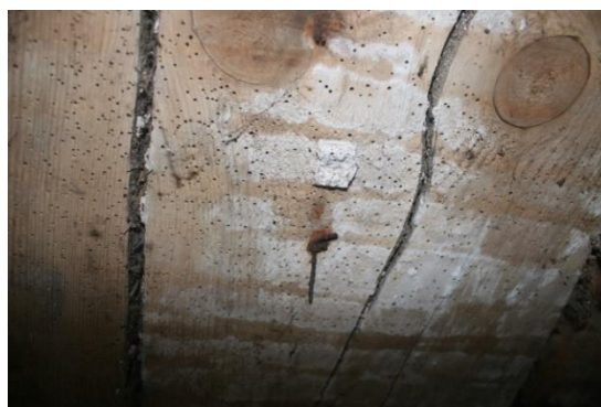
Obr. 52 Požerky červotoče pod věžičkou
