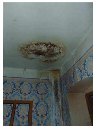
Obr. 45 Důsledek zatékání střechy - malovaná síň
