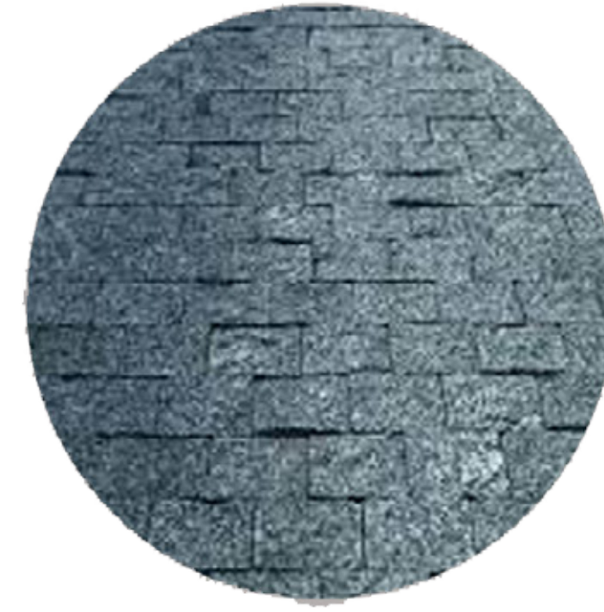
výplň tramvajového pásu v místě pěších zón - zvýraznění průjezdného profilu tramvaje
