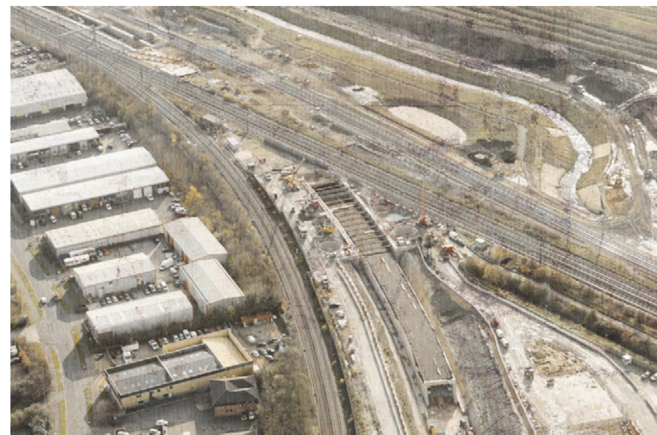
Náhled na konstrukci betonového tunelu. Protlačovaná konstrukce pod East Cost Main Line ve Velké Británii
