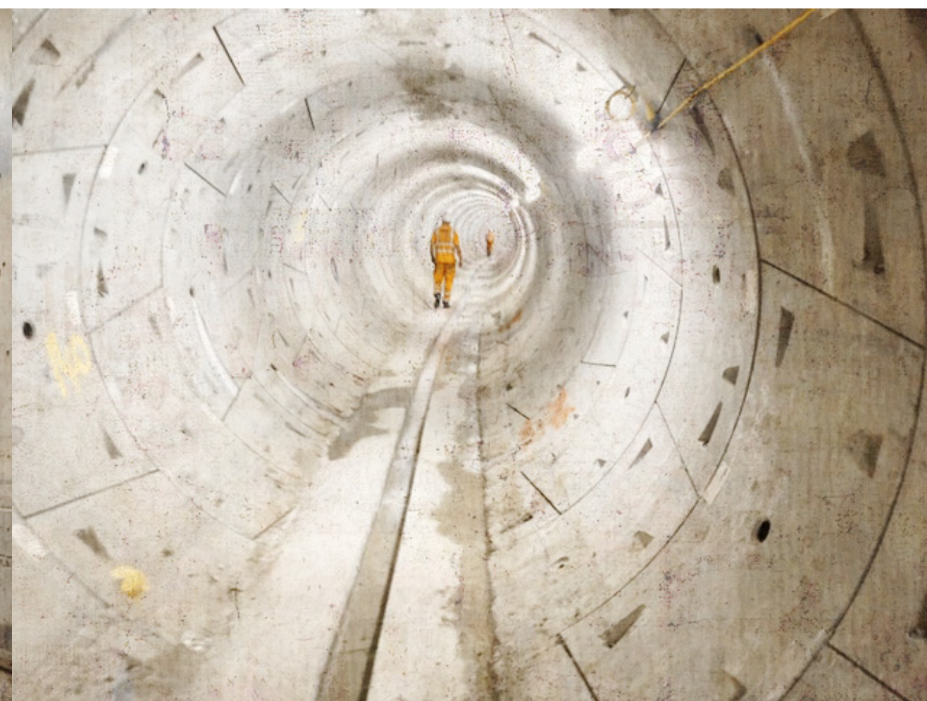
Vodící šachta protlačované konstrukce tunelu.
