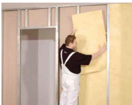
Obrázek 19: SDK - vložení minerální izolace do dutiny příčky
