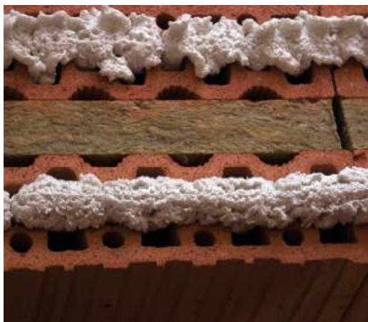
Obrázek 7: Heluz AKU Kompakt 21 - nanášení pěny
