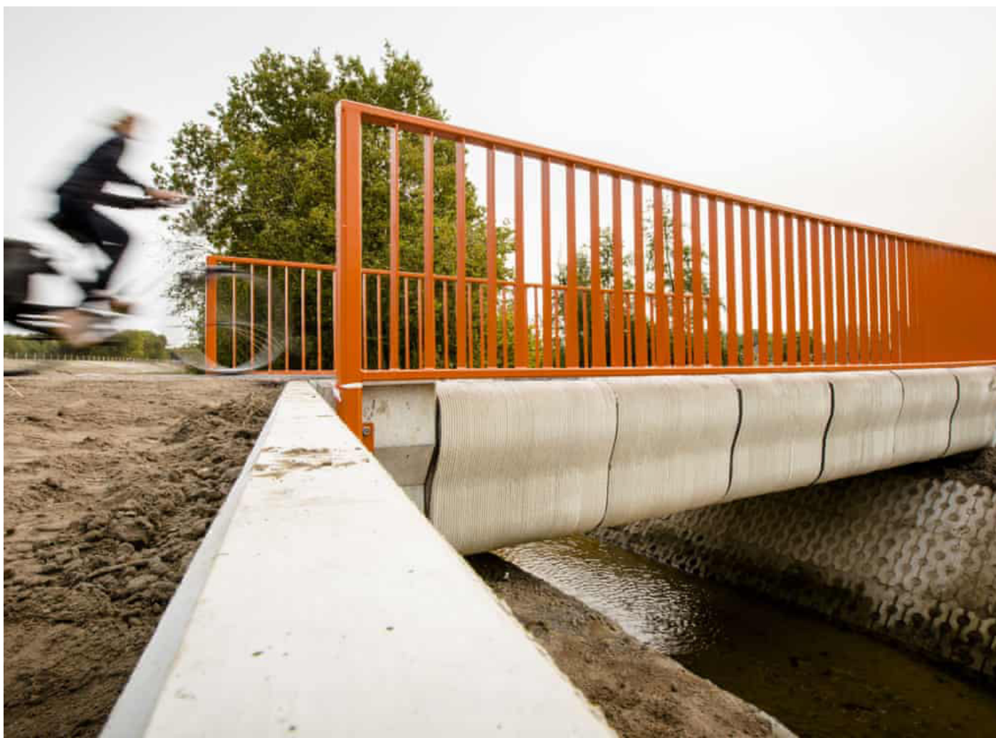
obr. 02 Most vytlačený technológiou 3D tlače z betónu
