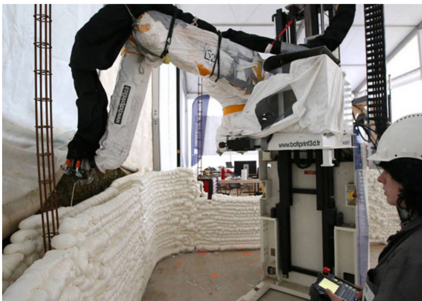
obr. 19 Proces 3D tlače stien domu pomocou robotického ramena
