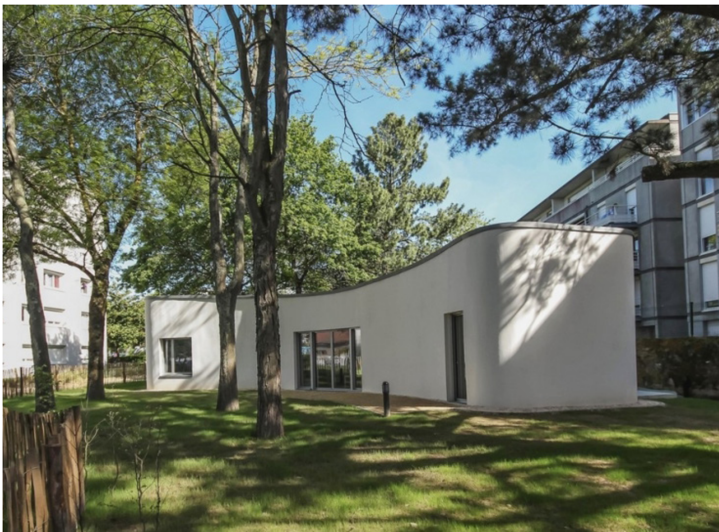
obr. 18 Fotografia 3D vytlačeného domu Yhnova
