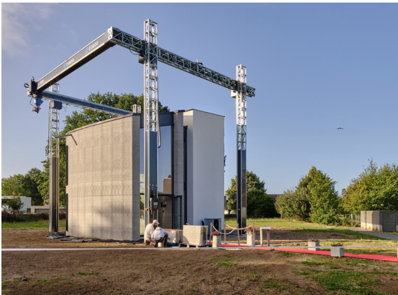
obr. 30 Fotografia 3D vytlačeného domu z betónu od organizácie Kamp C
