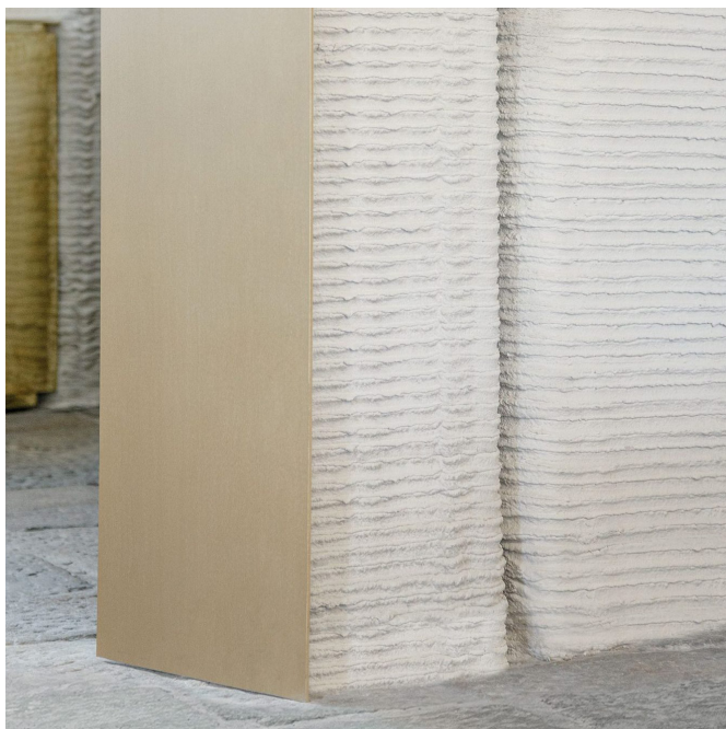
obr. 45 Textúra stien typická pre technológiu 3D tlače z betónu
