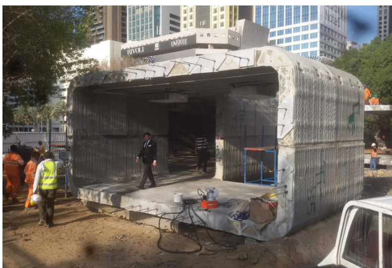
obr. 82 Spojené moduly tvorené hornou a dolnou kazetou
