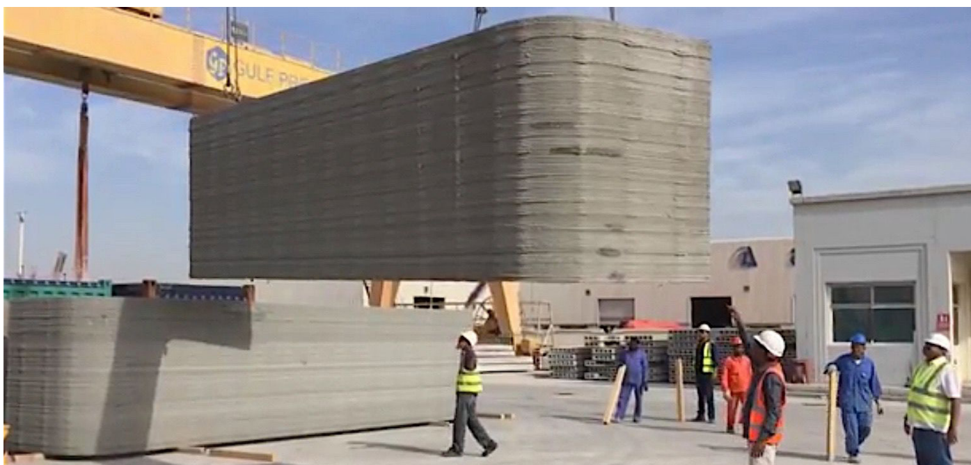
obr. 80 Transport prefabrikovaných častí budovy
