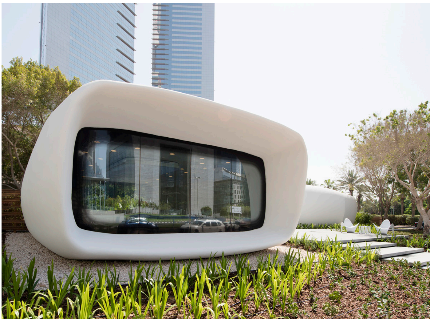
obr. 74 Prvá administratívna budova na svete vytlačená technológiou 3D tlače z betónu
