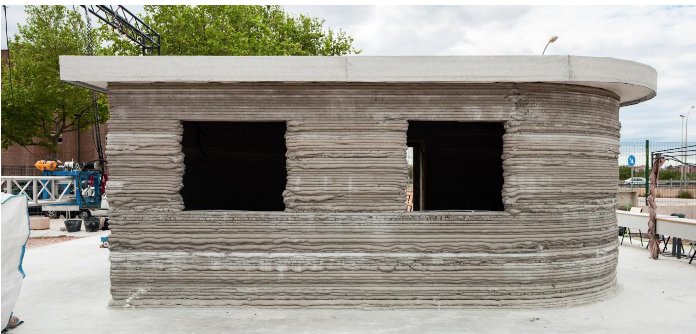
obr. 29 Hrubá stavba 3D vytlačenej konštrukcie domu
