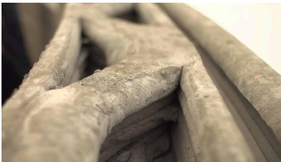
obr. 51 Štruktúra 3D vytlačenej betónovej steny tvorená štyrmi vrstvami betónu
