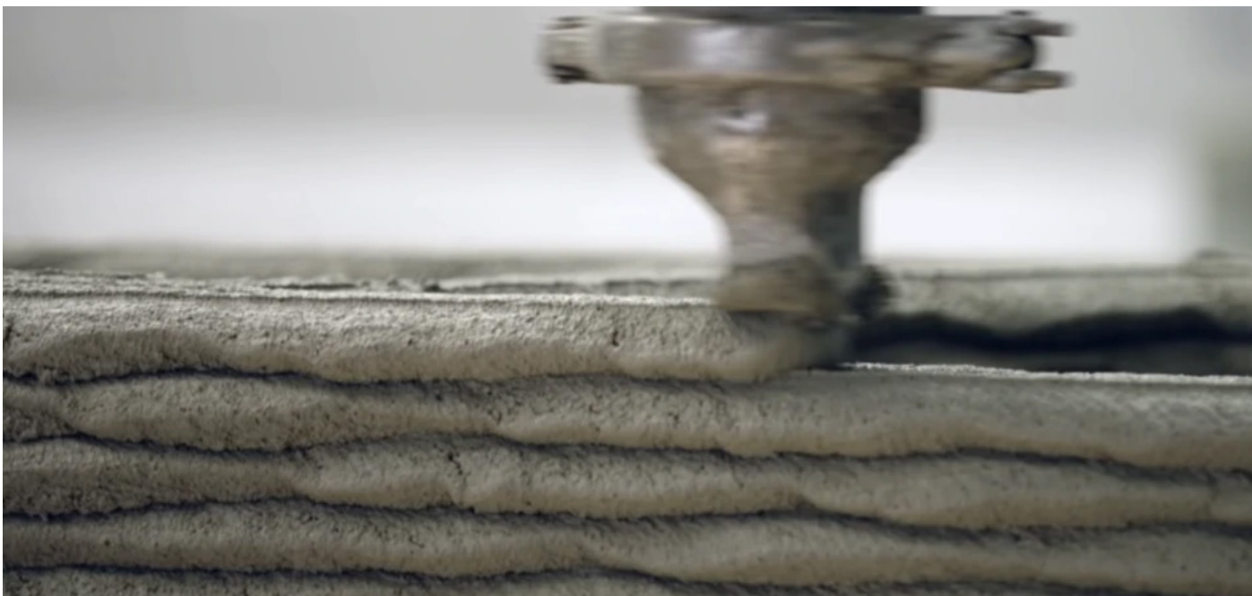
obr. 36 3D tlač betónovej steny
