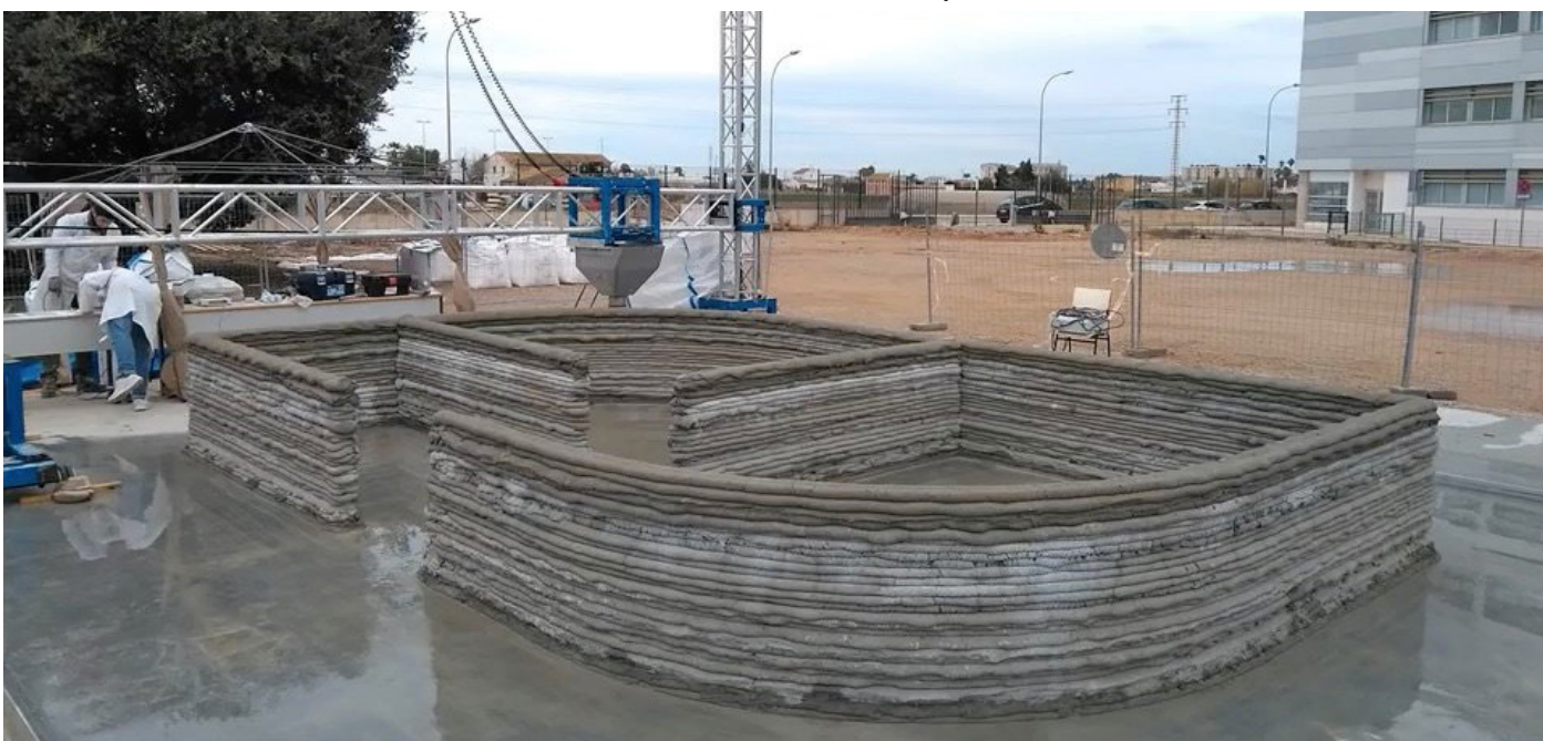
obr. 26 Proces 3D tlače portálovou tlačiarňou BEM PRO
