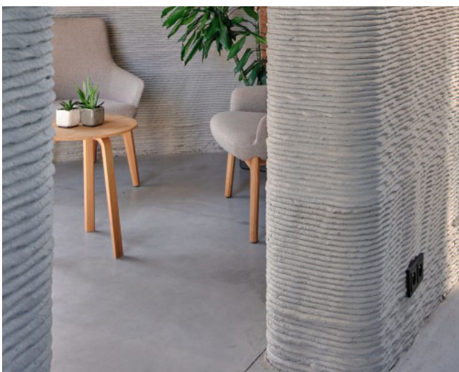
obr. 34 Textúra vrstiev steny priznaná v interiéri stavby
