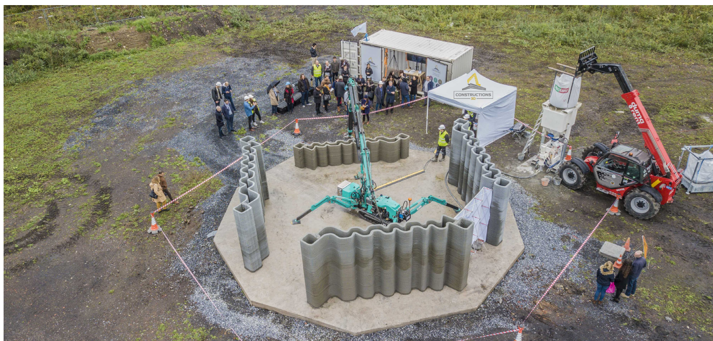
obr. 59 Proces 3D tlače budovy Le Pavillon
