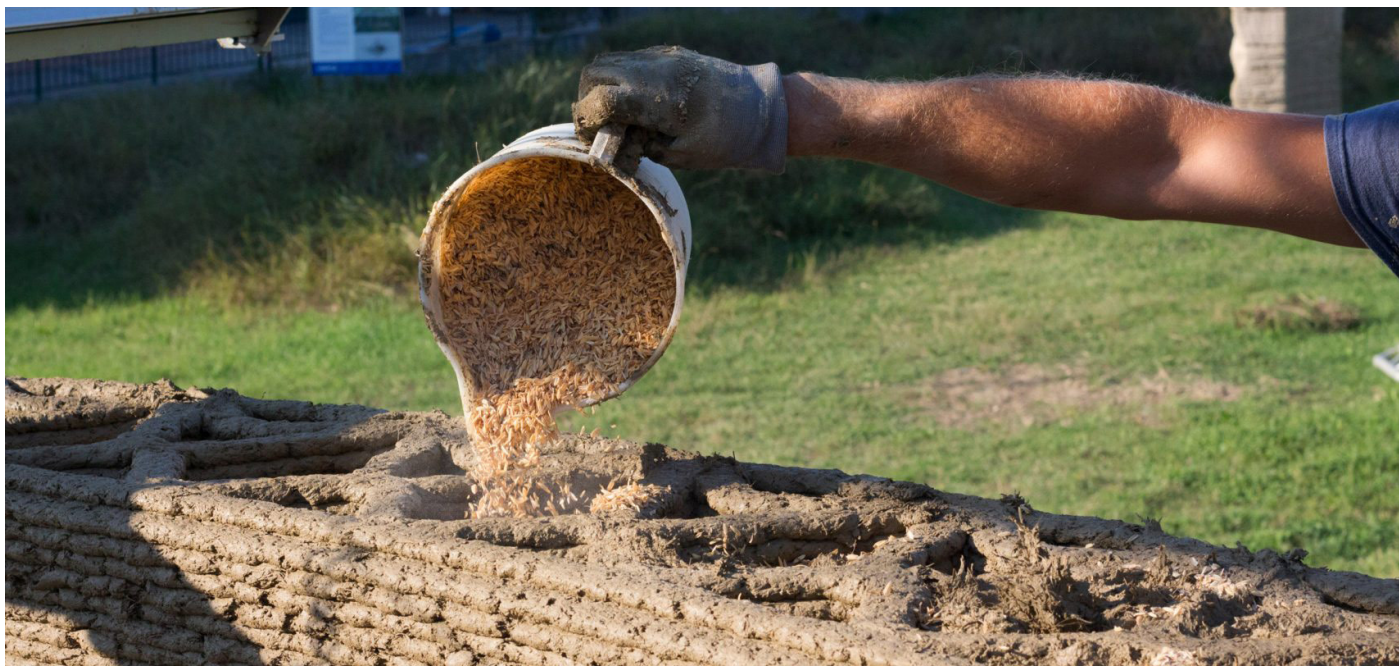
obr. 17 3D vytlačená stena bola tepelne izolovaná 20cm hrubou vrstvou ryžových pliev vo vnútorných dutinách steny [2.2]
