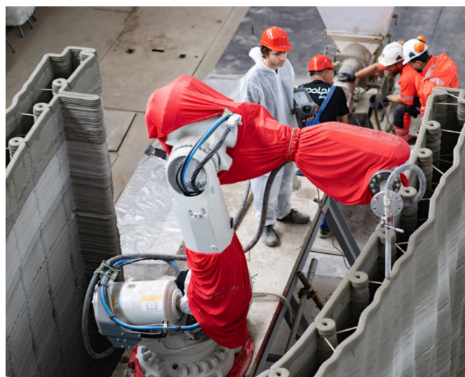
obr. 68 Proces 3D tlače steny Prvoka
