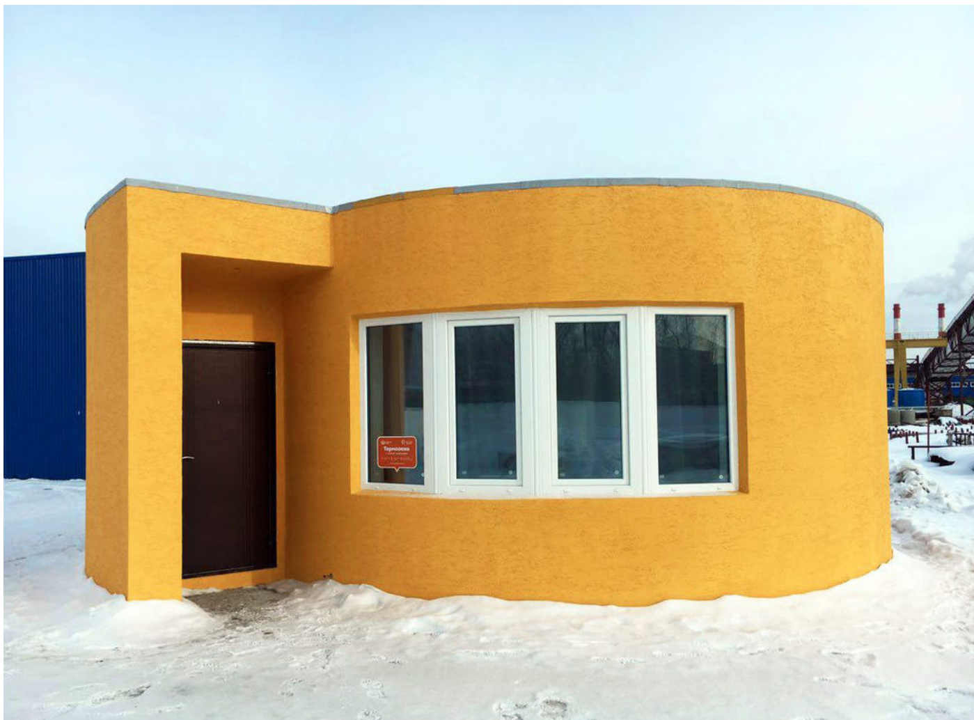
obr. 47 3D vytlačený dom z betónu od spoločnosti Apis Cor
