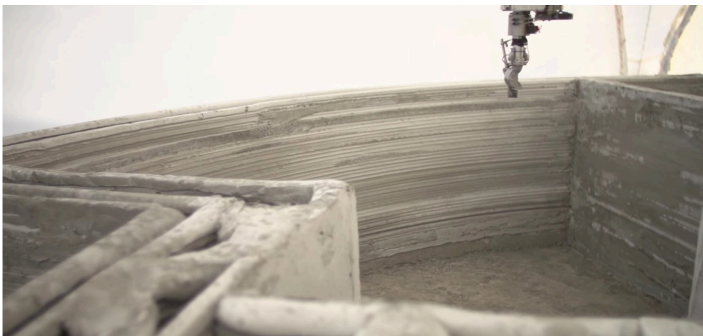
obr. 53 3D vytlačené betónové steny domu
