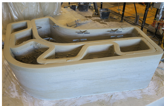
obr. 86 Vykonzolovaná časť steny s vnútornou štruktúrou na zvýšenie stability
