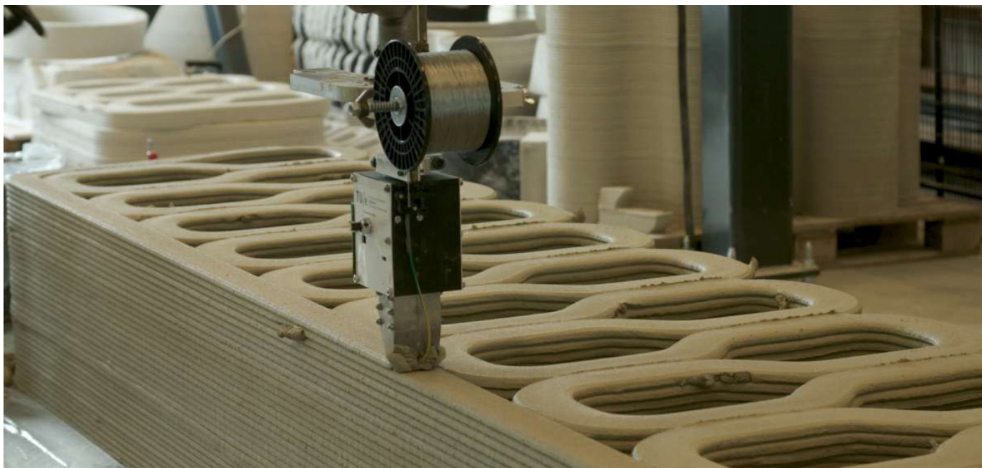
obr. 08 Vystužovanie vysokopevnostným oceľovým drôtom počas procesu tlače
