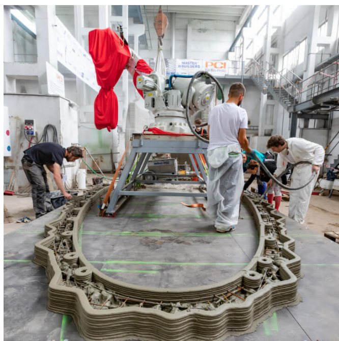
obr. 72 Prvé 3D vytlačené vrstvy steny
