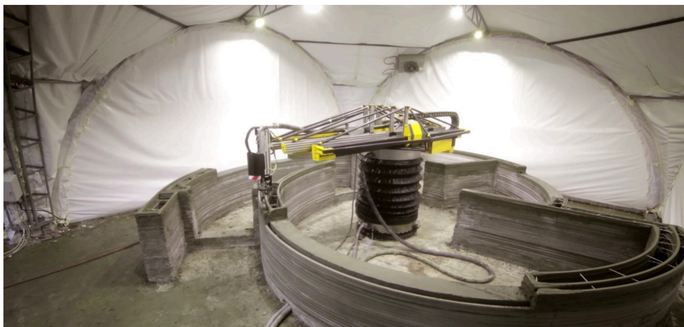
obr. 50 Proces 3D tlače domu pomocou robotického ramena v krytom stane
