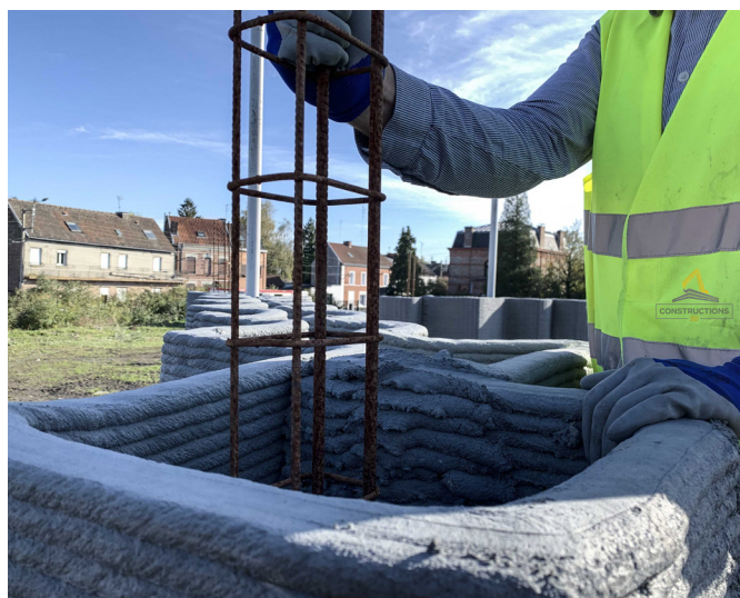
obr. 61 Štandardná stavebná výstuž v dutine steny
