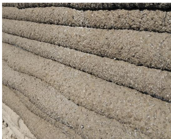
obr. 28 Betónová zmes ukladaná v jednotlivých vrstvách
