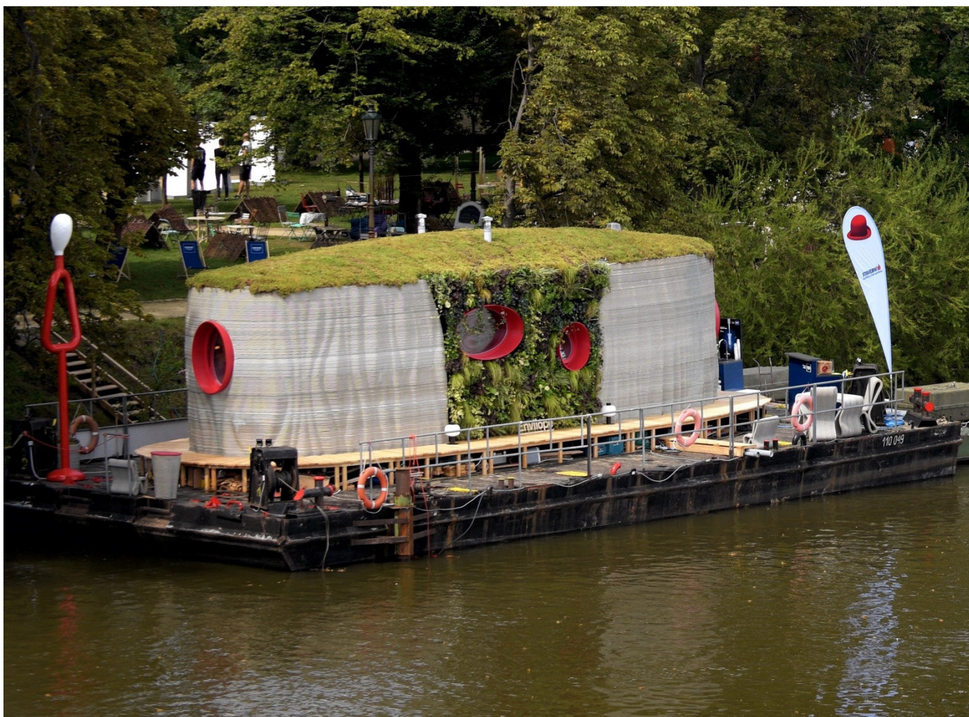
obr. 63 Prvý 3D vytlačený dom z betónu v Českej republike
