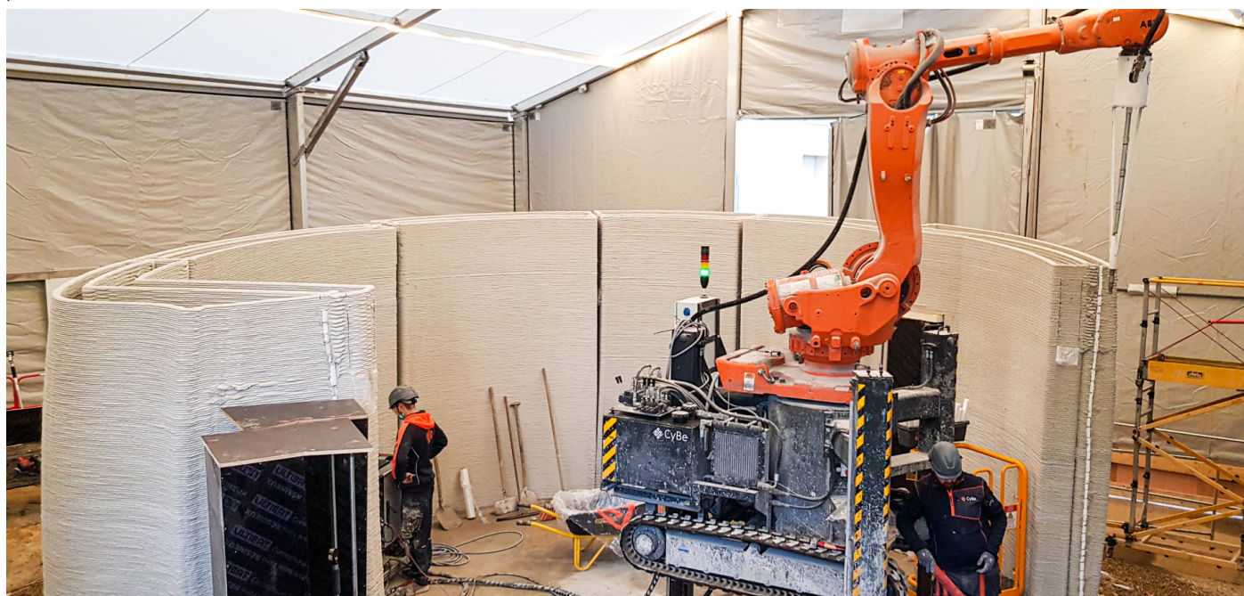
obr. 43 Robot CyBe RC 3Dp počas tlače budovy s názvom „La Sphère“ v Normandii
