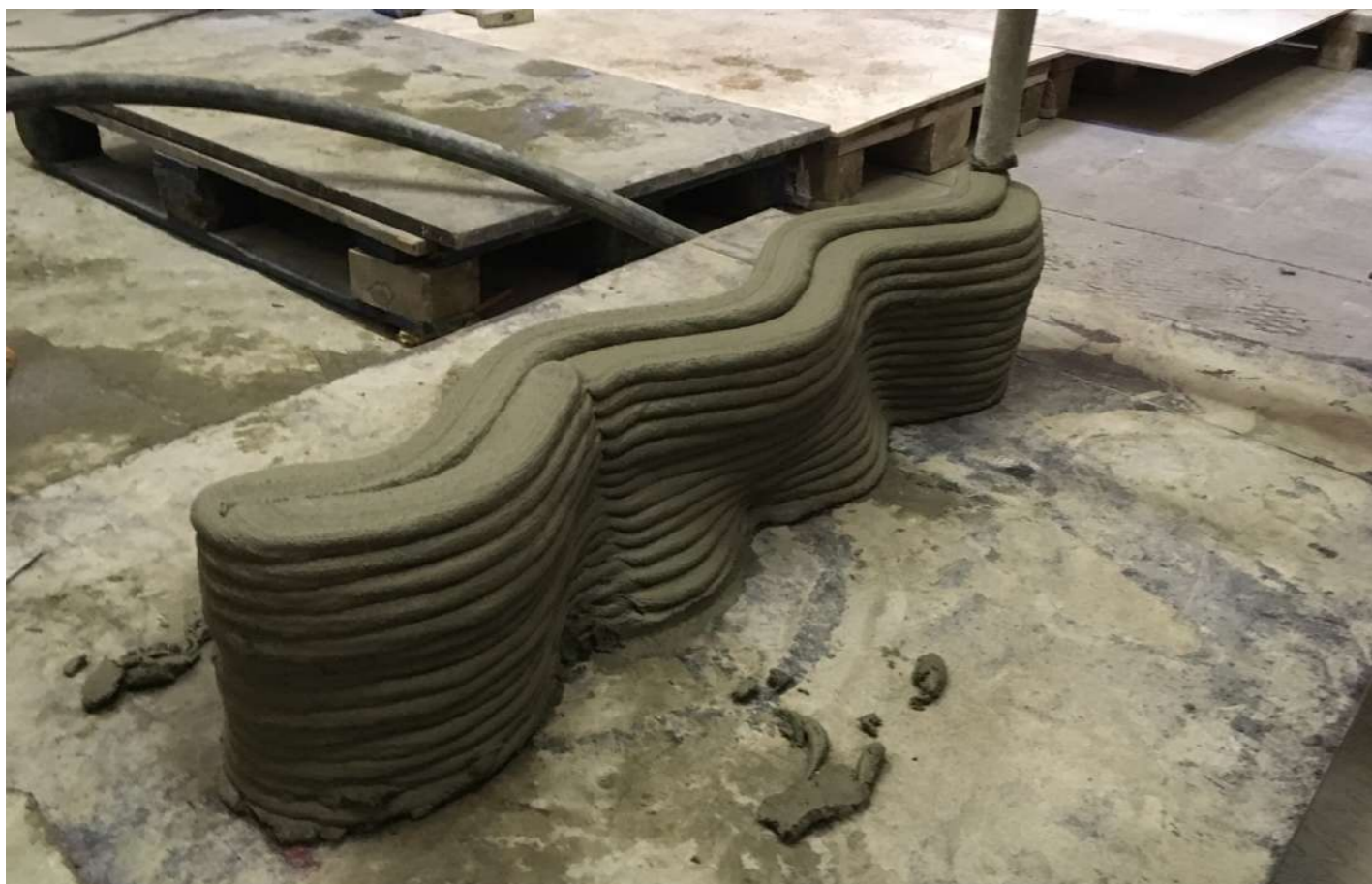
Tlač 15. vrstvy. Sú vytlačené značné previsy bez náznaku kolapsu. Na stene je vidno vertikálnu hranicu, na ktorej sa tryska robota dvíha o jednu vrstvu (koniec vytlačenej vrstvy a začiatok novej) vrstvy).
