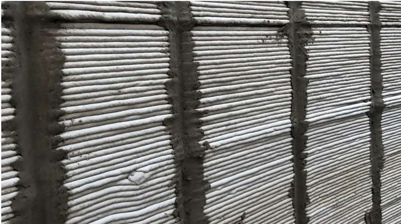
Obr. 12 Vzhľadom na to, že pri tlači nosných stĺpikov dochádzalo k tvorbe štrbín kvôli nedokonalému prelínaniu vrstiev, bolo po tlači stien potrebné medzery vyplniť.
