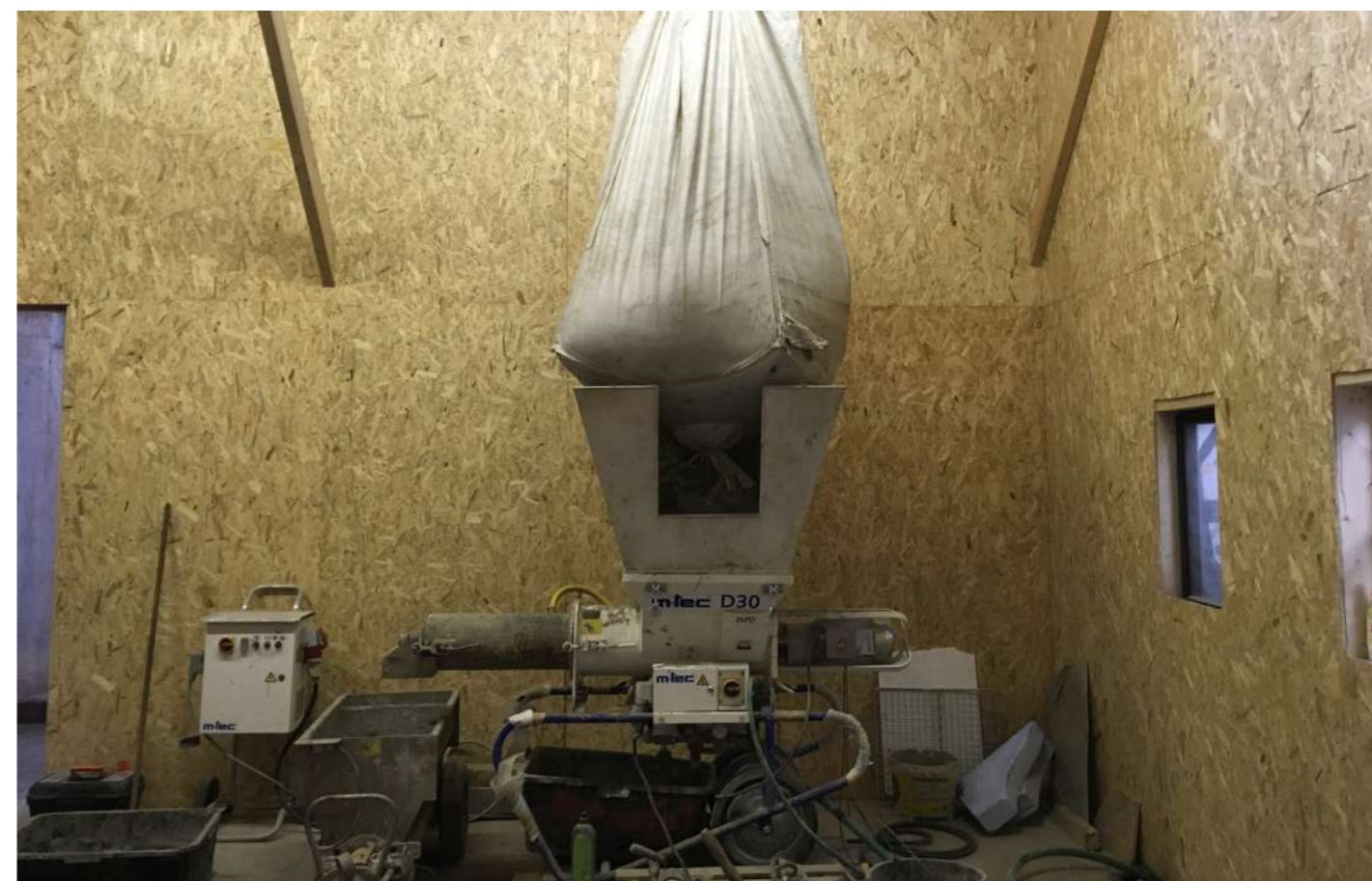
Žeriavom v hale je nad kontinuálnu miešačku umiestnené vreco so špeciálnou betónovou zmesou MasterFlow 3D 100.
