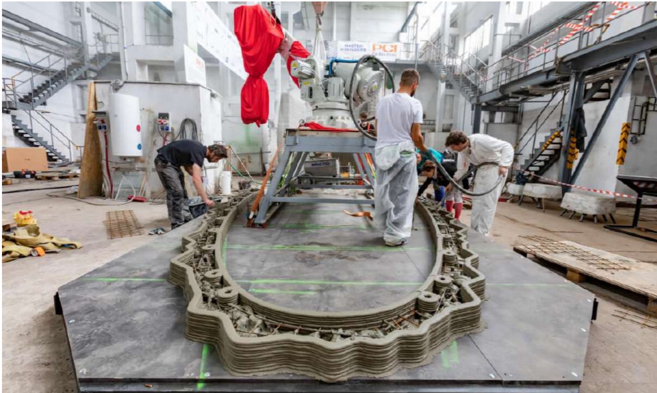
Obr. 9 V prípade stavby Prvoka bol 3D vytlačeným obvodovým stenám vytvorený základ vystužený kari sieťou. Prvé 3D vytlačené vrstvy slúžili ako stratené debnenie.
