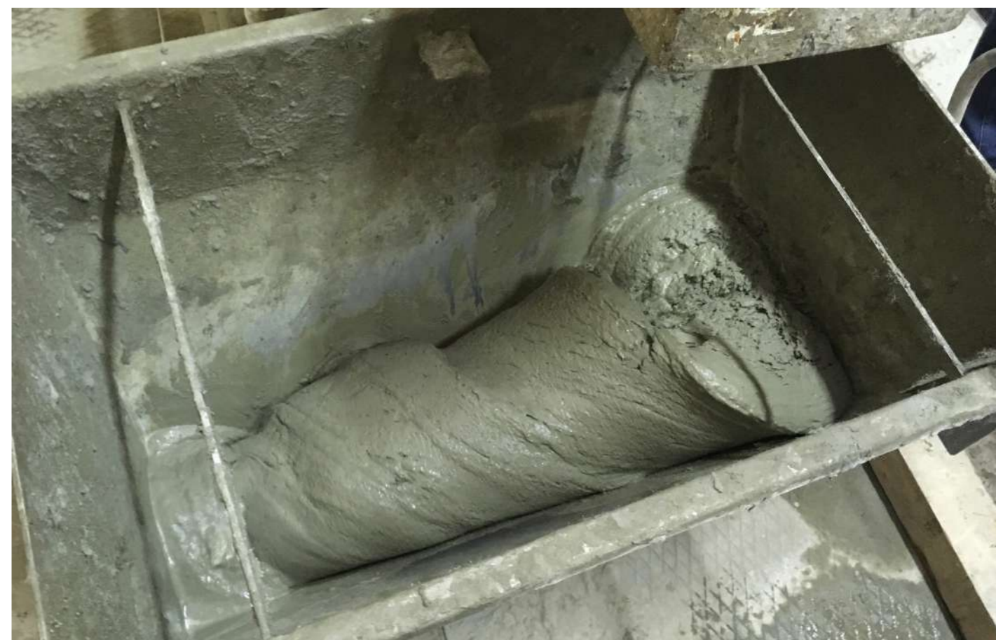
Správna konzistencia betónu v šnekovej pumpe.
