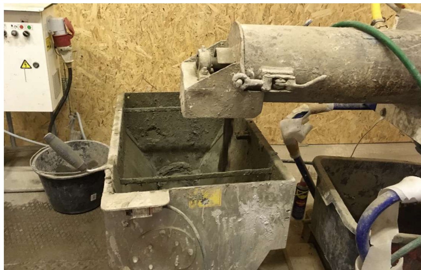
Prúdenie betónu z kontinuálnej miešačky do šnekovej pumpy.
