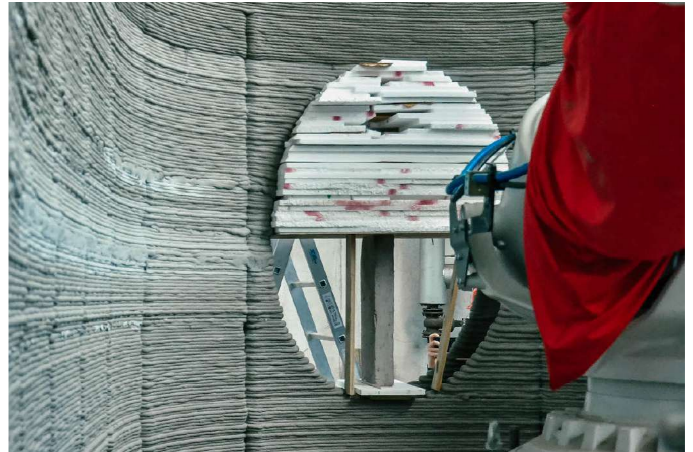
Obr. 14 Ku kritickým detailom 3D tlačených konštrukcií patria jednoznačne previsy. Na základe skúseností pri tlači Prvoka, bol stanovený kritický uhol previsu na 15^\circ pri použití materiálu Master-Flow 3D 100. Počas tlače muselo byť nadpražie okna podopreté debnením. Väčšie previsy by bolo možné dosiahnuť použitím materiálu s odlišnými vlastnosťami.
