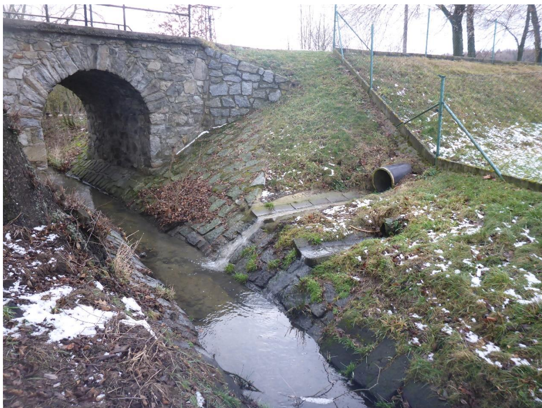
Obr. 11 Začátek řešeného úseku (Propustek u obce Humenec)
