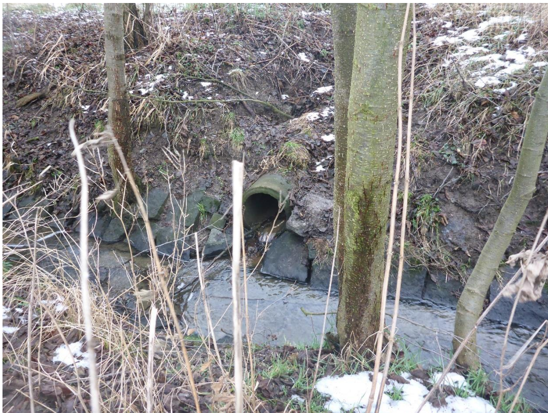
Obr. 4 Výtok z odvodnění na pravém břehu
