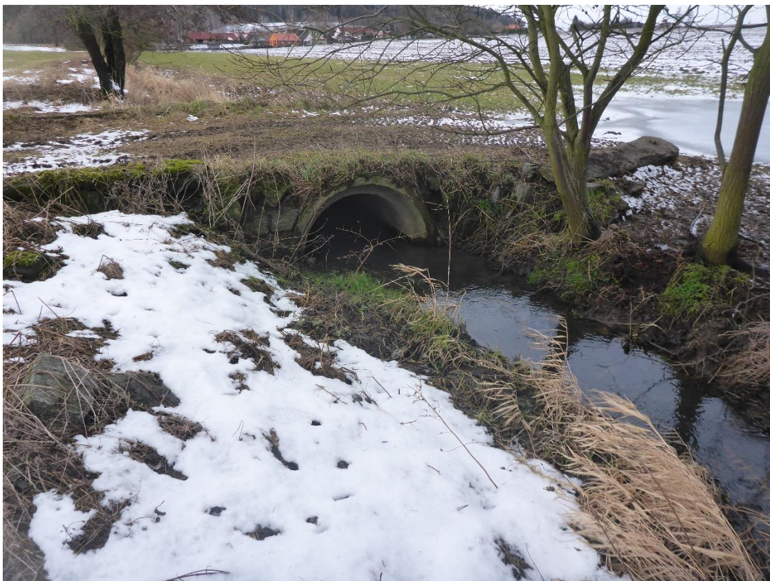
Obr. 8 Spodní propustek
