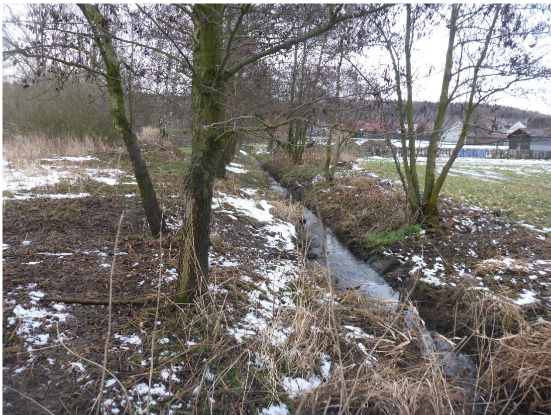
Obr. 10 Nejspodnější úsek koryta
