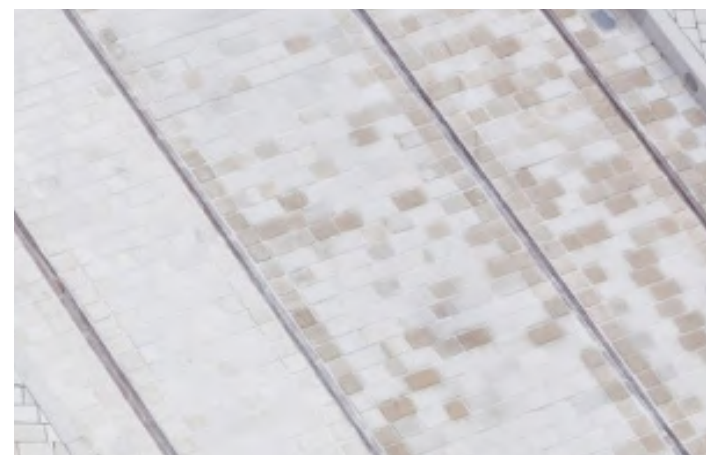
04 | Tramvajová zastávka | Velkoformátová žulová dlažba
