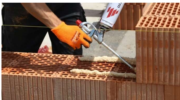
Obrázek 9: Aplikace pěny Porotherm Dryfix
