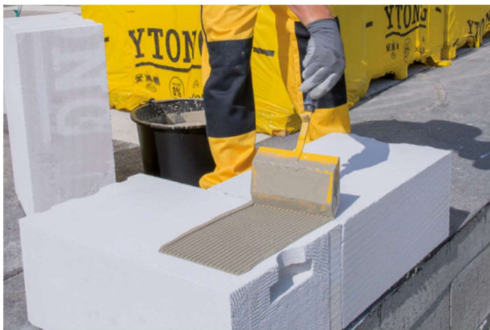
Obrázek 14: Nanášení malty na Ytong
