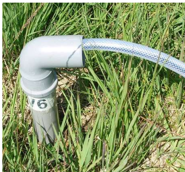
Obrázek 6 – Pozorovací vrt DV pro měření hladiny podzemní vody
