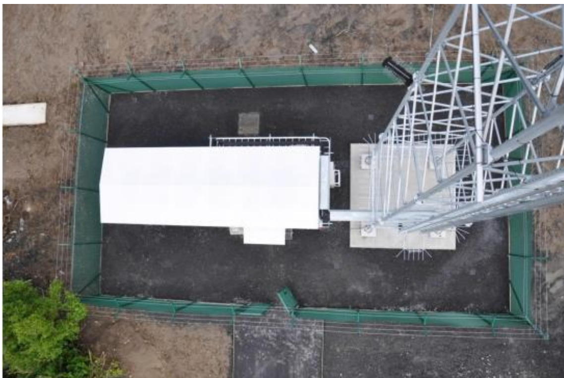
Servisní místnost u věže r-TWR. Zdroj: [43]
