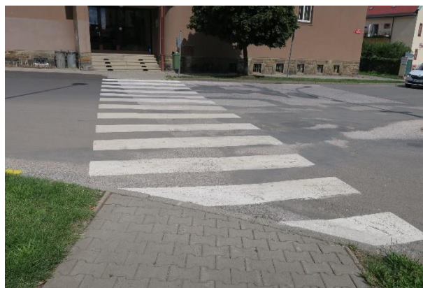
Obrázek 5.21: Pohled na západně situovaný přechod pro chodce v těsné blízkosti stykové křižovatky, kde na snímku je zobrazena absence prvků OOSPO, neadekvátní délka přechodu a špatný bezbariérový přístup.
