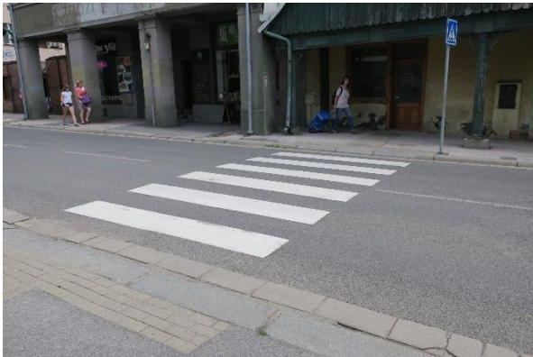
Obrázek 5.28: Ukázka neadekvátní bezbariérovosti u přechodu pro chodce.
