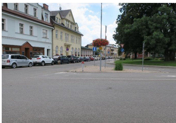
Obrázek 5.26: Ukázka opotřebeného VDZ V 6b v místě napojení vedlejšího ramena do křižovatky.
