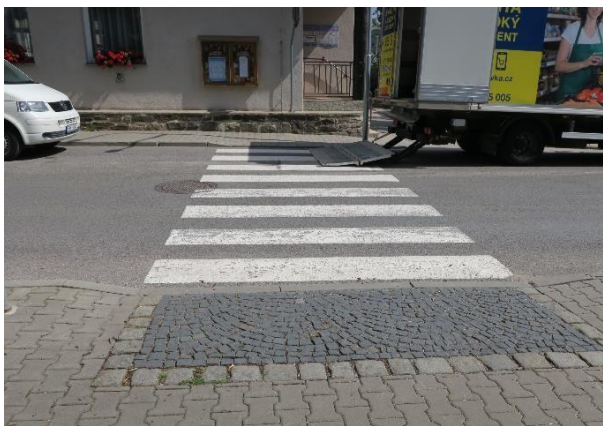
Obrázek 5.30: Ukázka absence prvků pro OOSPO na přechodu pro chodce.
