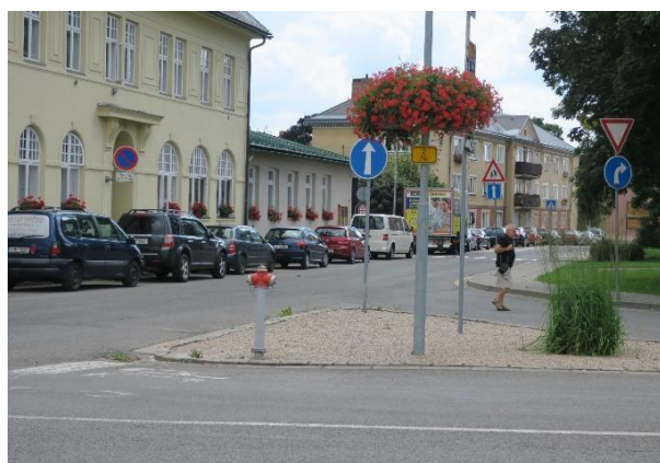
Obrázek 5.27: Detail na opotřebené VDZ na rameni Pražská.
