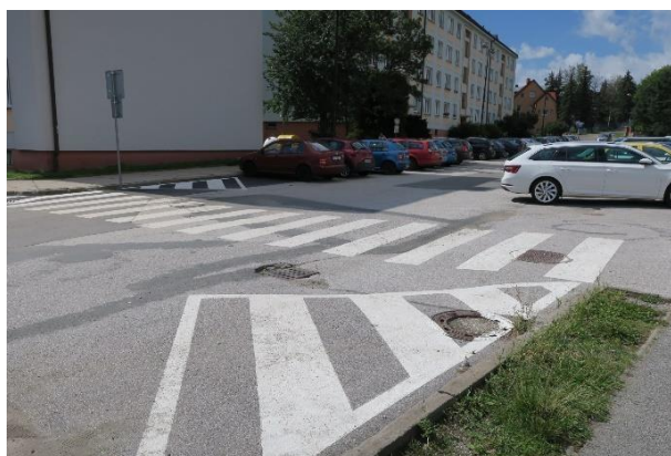
Obrázek 5.22: Pohled na západně situovaný přechod pro chodce, kde na snímku je zobrazena absence prvků OOSPO, neadekvátní délka přechodu a špatné rozhledové poměry.
