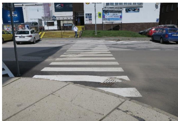
Obrázek 5.23: Pohled na západně situovaný přechod pro chodce z opačné strany, kde na snímku je zobrazena absence prvků OOSPO, neadekvátní délka přechodu a špatné rozhledové poměry.
