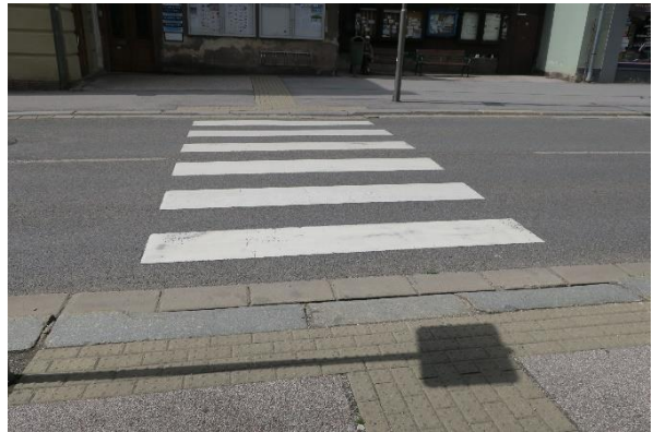
Obrázek 5.29: Ukázka neadekvátní bezbariérovosti u přechodu pro chodce z opačné strany.
