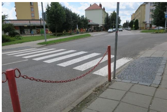
Obrázek 5.18: Pohled na západně situovaný přechod pro chodce, kde na snímku je zobrazena absence signálního a varovného pásu, vodící linie a neadekvátní délka přechodu.
