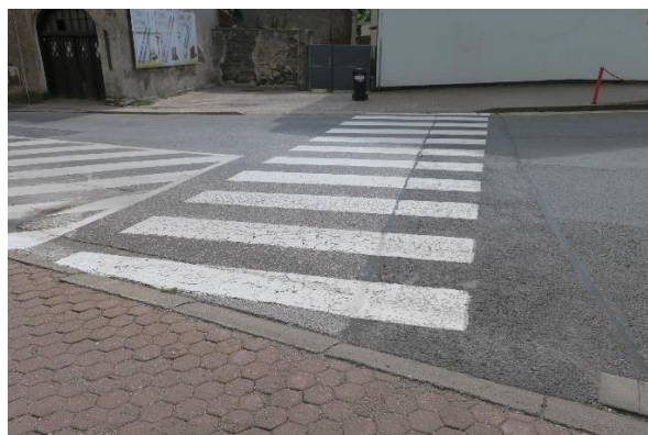
Obrázek 5.15: Ukázka absence signálního a varovného pásu, na jedné straně přechodu, vodící linie, značné délky přechodu.
