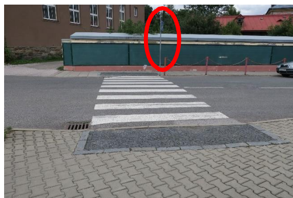
Obrázek 5.19: Pohled na západně situovaný přechod pro chodce z druhé strany, kde na snímku je zobrazena neadekvátní kombinace SDZ P 2 a IP 6.
