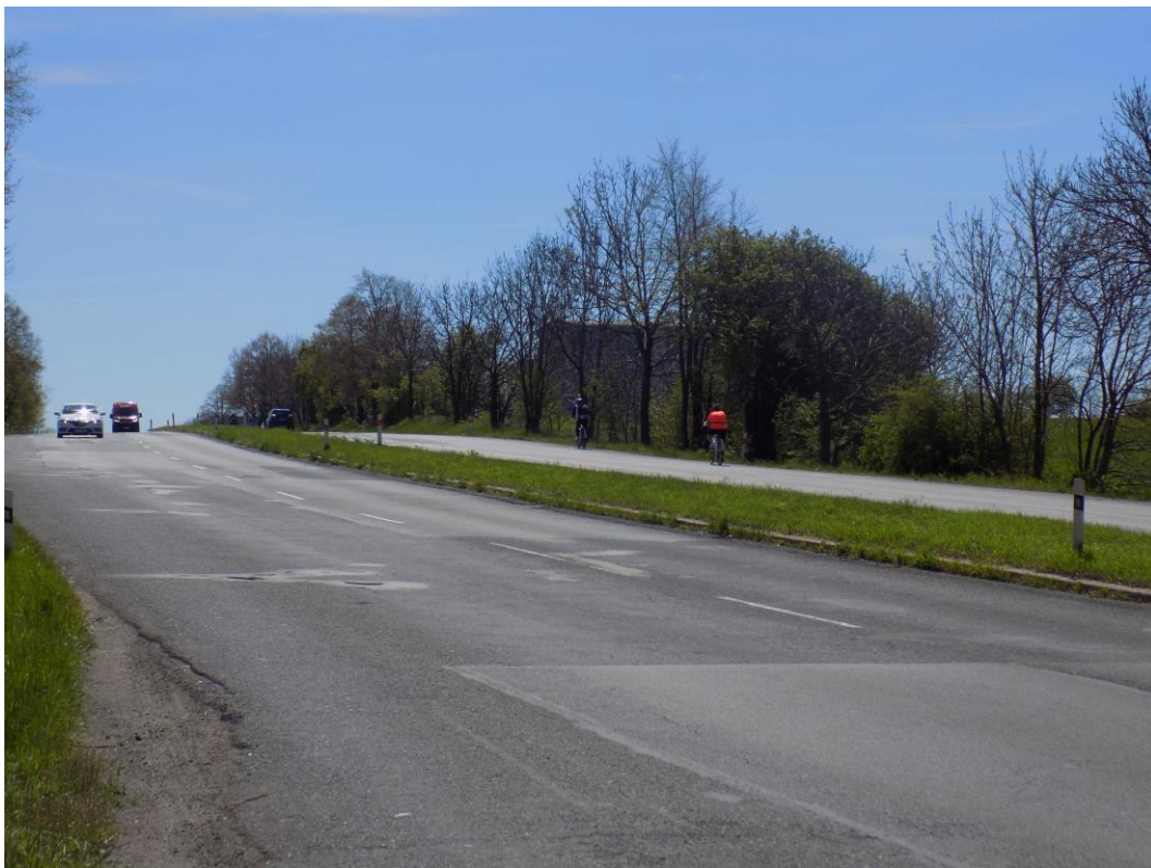
Obrázek 9 - Nebezpečné vedení cyklistů v ulici Pražská
