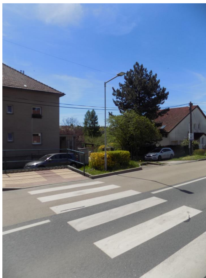
Obrázek 16 - Přechod pro chodce v ul. Průběžná s přisvětlením pomocí solárního napájení
