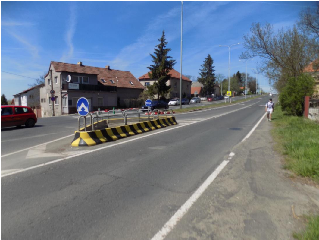
Obrázek 12 - Chybějící infrastruktura pro pěší podél ul. Pražská
