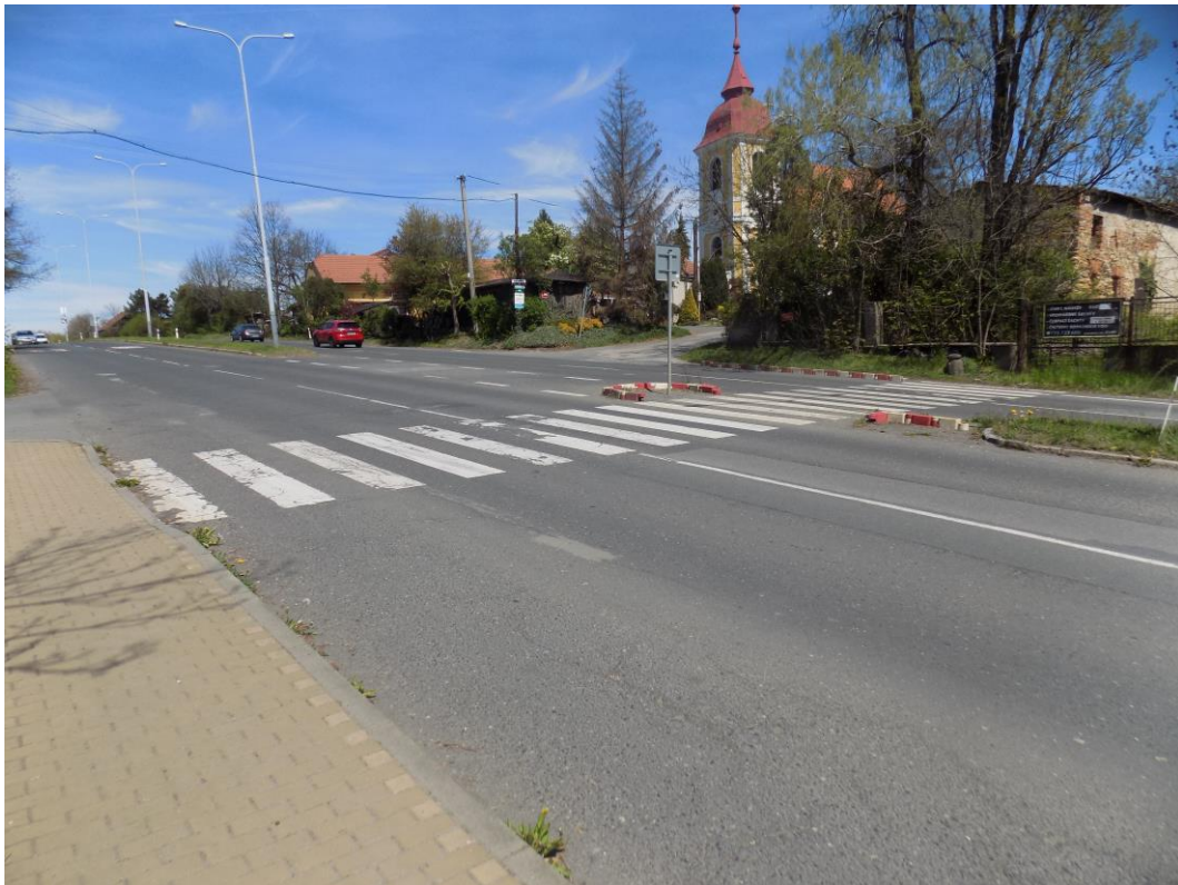
Obrázek 6 - Přechod pro chodce přes ulici Pražská
