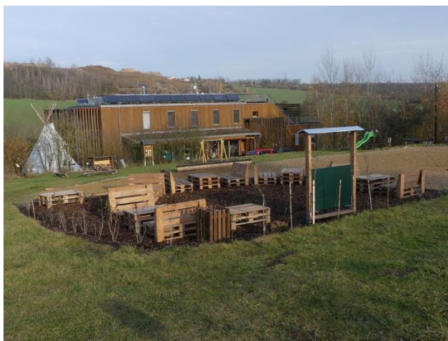
Obrázek 2.13 Budova střediska a venkovní učebna
