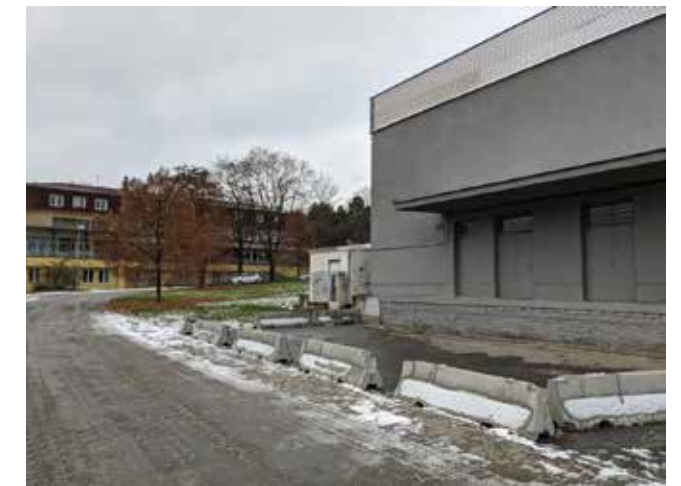
nevyužité prostory pod Normou unused space below Norma
