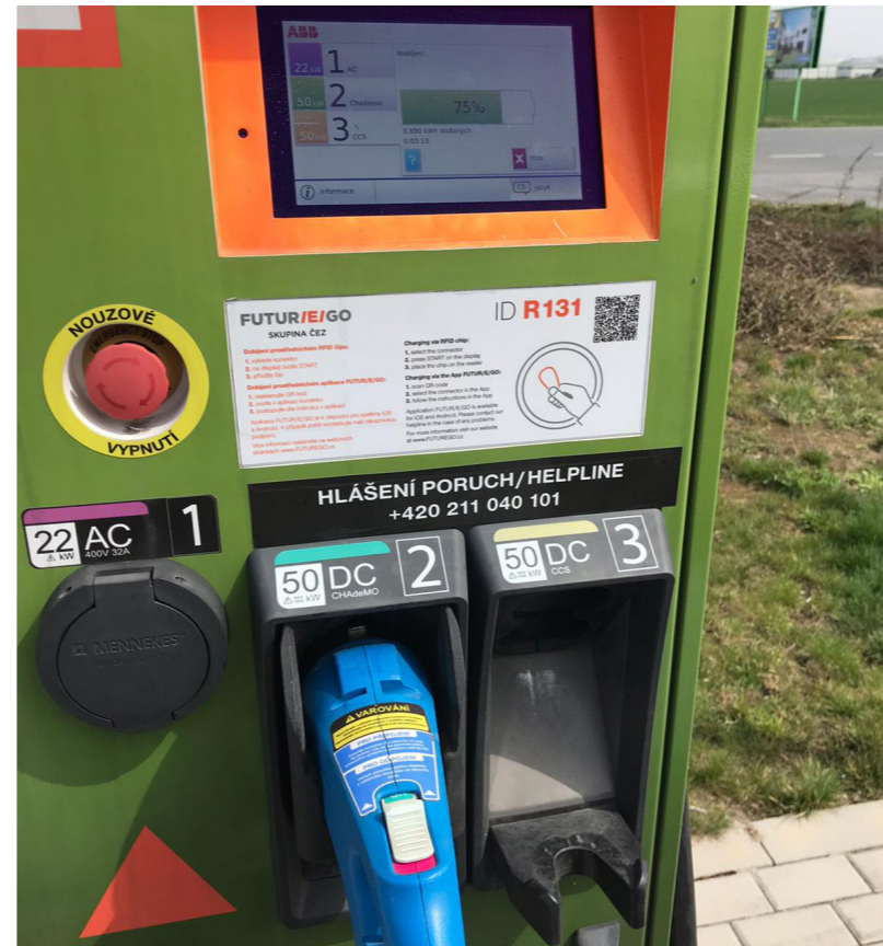
Informační panel s ovládáním nabíječky
