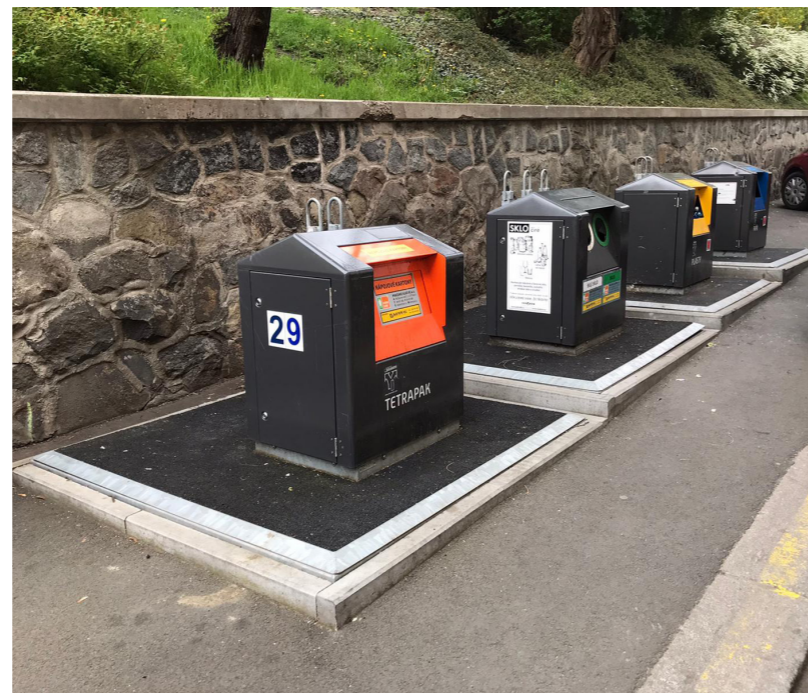
Zapuštění košů pro třízený odpad do země
