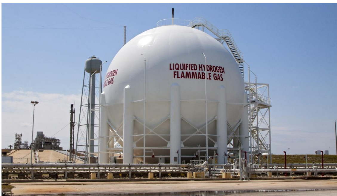
Obr. III.IV: Nádoba na uskladnění tekutého vodíku [36]
