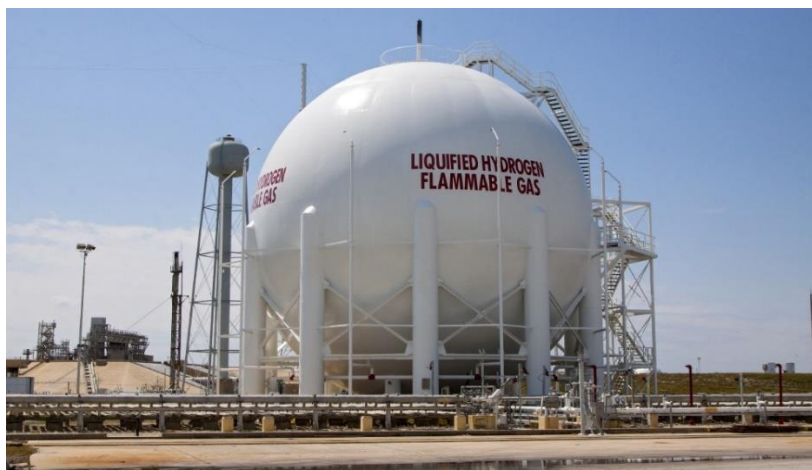
Obr. 2.6: Nádoba na uskladnění tekutého vodíku [36]
