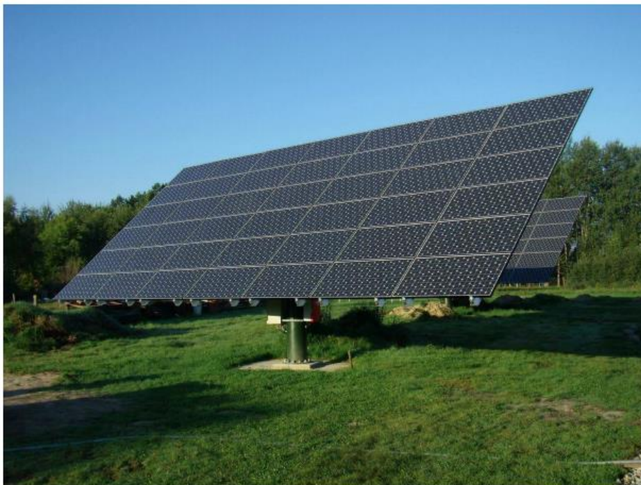
Obrázek 18: FV panely s dvouosým natáčením [17]
