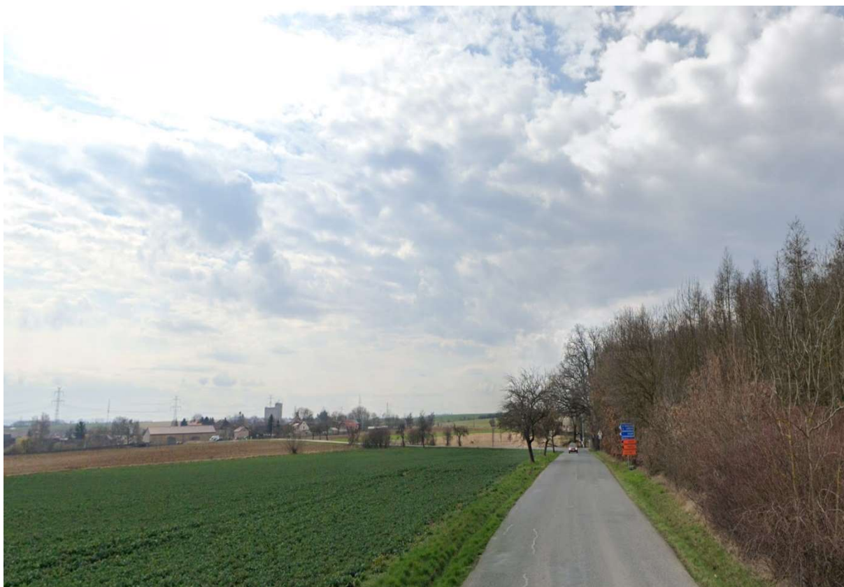
Obr. 21 - km 2-0,00000 Začiatok úseku 2
