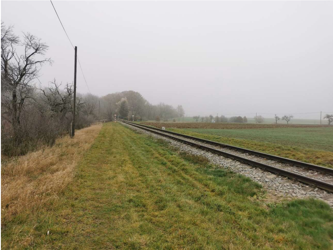
Obr. 22 - km 2-0,43500 Miesto budúceho mostu ponad žel. Vlečku
