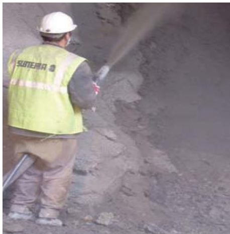
Obr. 7 Ruční stříkání betonu do výrubu operátorem trysky.
