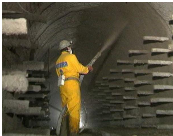
Obr. 5 Fotografie z realizace kolektoru Na Příkopech – výstavba.
