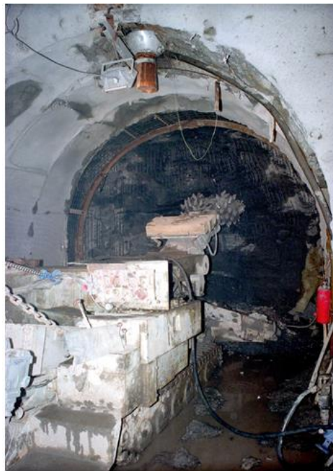
Obr. 3 Pohled do výrubu kolektoru 2. kategorie, ražba výložníkovou frézou, rámy + stříkaný beton
