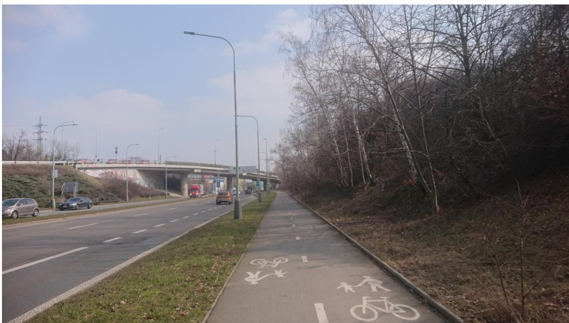
Fotografie 8: Pohled na ulici Chlumecká a stávající cyklostezku. V pozadí lze spatřit most přes Chlumeckou ulici, hlavní problematické místo Úseku 2. Pohled ve směru staničení.
