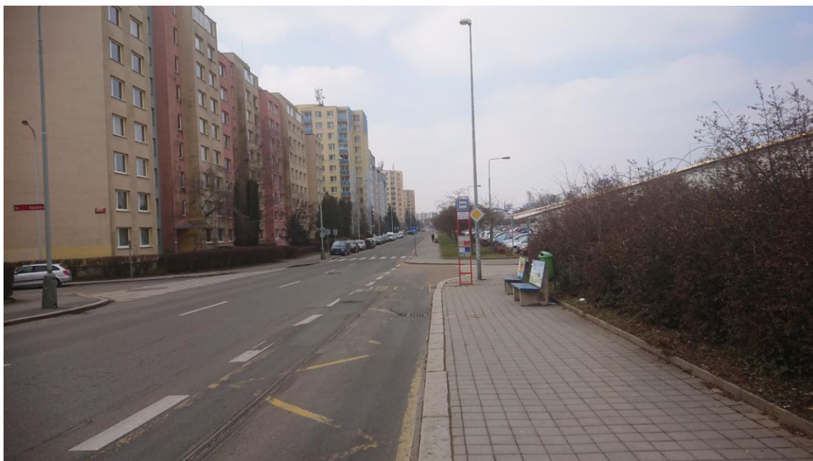
Fotografie 26: Autobusová zastávka Ronešova bude v případě realizace Varianty B Úseku 3 sdružena se zastávkou tramvají s nevstřícným umístěním nástupišť. Pohled proti směru staničení.
