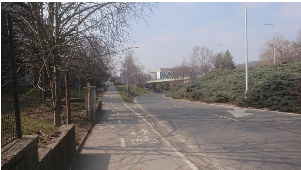
Fotografie 5: Ulice Kolbenova se stávající cyklostezkou. V pozadí se nachází most Poděbradské ulice - větev z centra. Pohled proti směru staničení.
