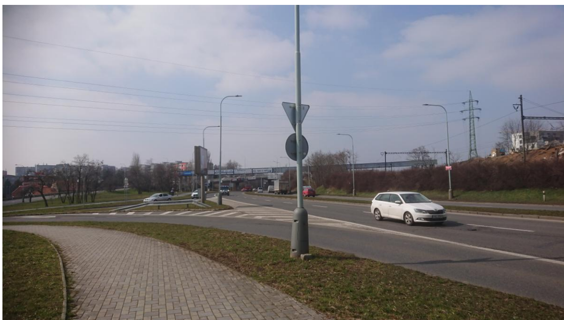
Fotografie 18: Křížení ulic Chlumecká a Broumarská. V pozadí lze spatřit most přes Chlumeckou ulici. Foceno z cyklostezky.
