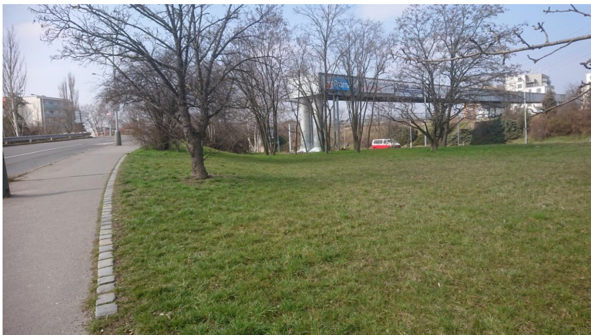
Fotografie 14: V prostoru mezi kolektorem a ulicí Cíglerská se po realizaci Varianty A Úseku 2 bude nacházet tunelový portál. Pohled proti směru staničení.
