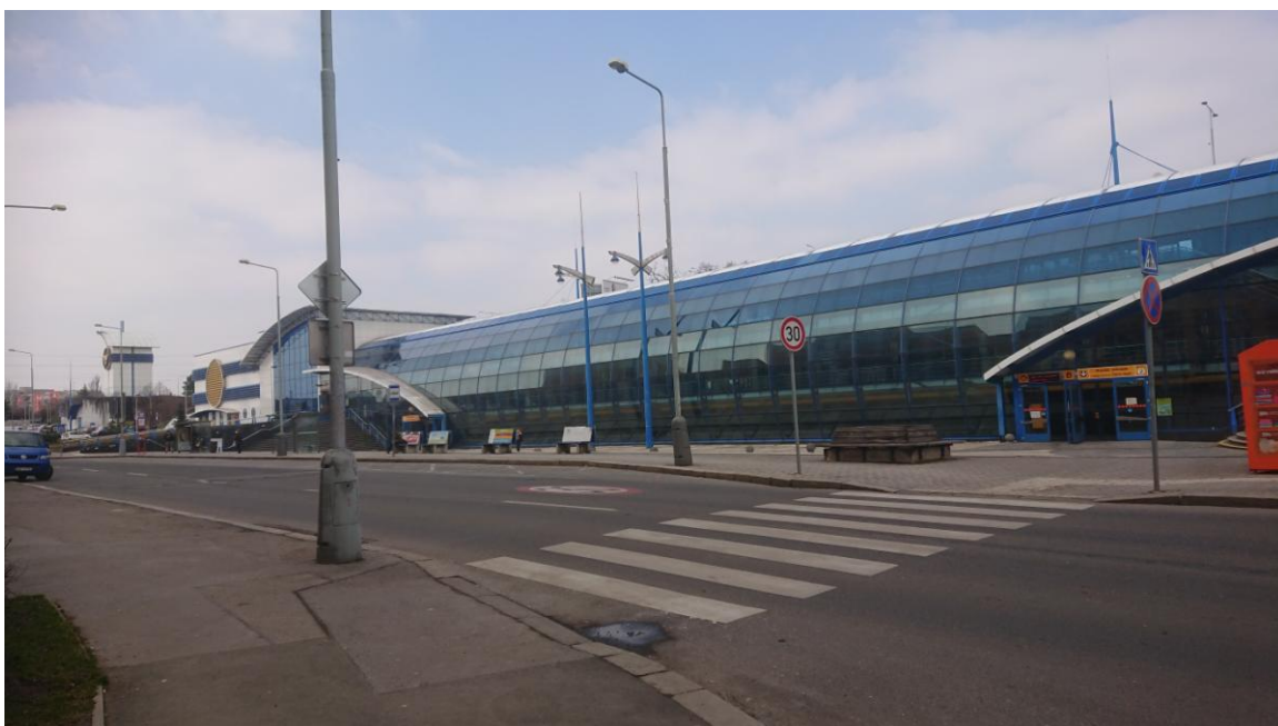
Fotografie 24: Pohled na stanici Rajská zahrada. Před stanicí lze spatřit stejnojmennou autobusovou zastávku, která v případě realizace Varianty B Úseku 3 bude sdružena se zastávkou tramvají.
