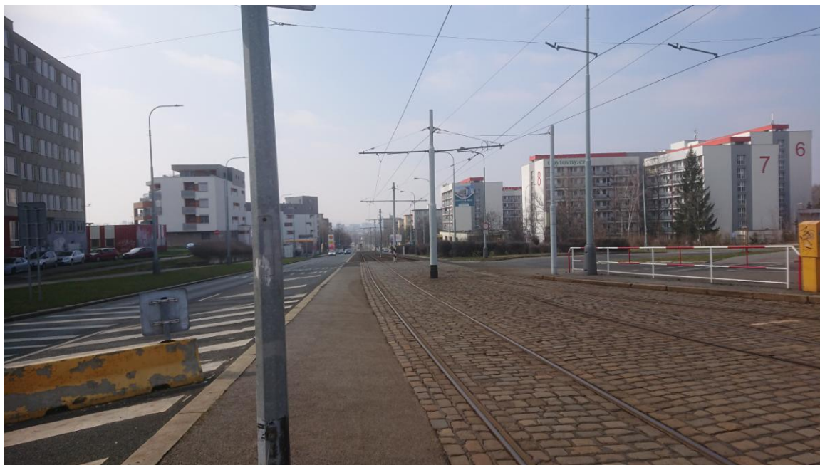
Fotografie 1: Stávající tramvajová trať v ulici Poděbradská nedaleko vjezdu do prostoru tramvajového obratiště Lehovec. Pohled proti směru staničení.
