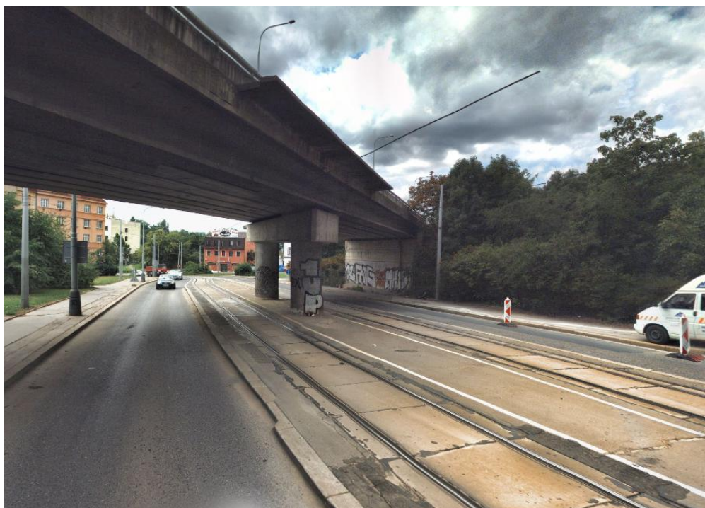
Obrázek 5: Mimoúrovňové křížení ulic Zenklova a Povltavská v Praze, příklad vedení kolejí tramvajové trati okolo mostního pilíře z obou stran [25]
