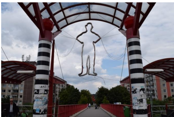
Obr. č. 36 Vstup na náměstí od tramvaje
