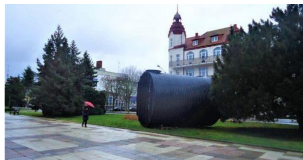
Obr. č. 27 Dešťové nádrže
