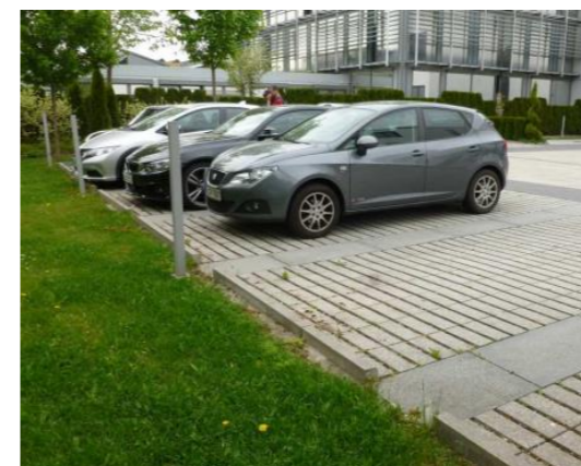
Obrázek 32: Snížený obrubník pro umožnění vsaku dešťových vod
