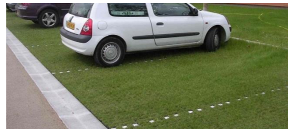
Obrázek 35: Realizace zatravněvací dlažby na parkovišti
