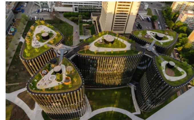
Obrázek 21: Zelená střecha budovy Main Point
