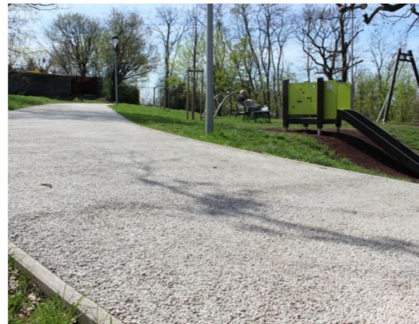
Obrázek 37: Realizace drenážního betonu v parku
