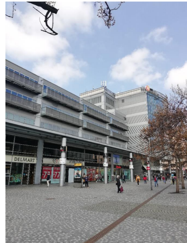
Obrázek 73: Budova komplexu Zlatý anděl vhodná pro realizaci zelené fasády
