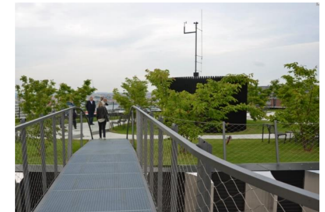
Obrázek 22: Detail zelené střechy budovy Main Point
