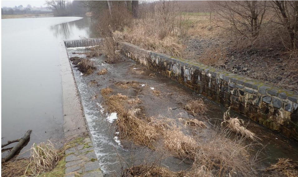
Obrázek 3: Boční přeliv na MVN v obci Zlonice, okr. Kladno (foto autor, leden 2021)
