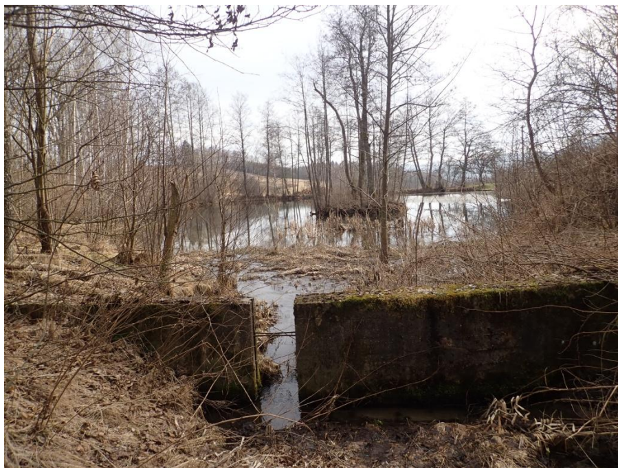
Obrázek 26: Současný stav přehrážky (pohled směrem do nádrže)
