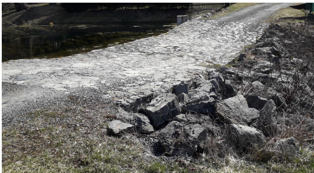
Obrázek 2: Přímý přeliv řešený jako průleh v hrázi s mírnými sklony břehů pro pojezd vozidel – opevnění provedeno kamennou dlažbou, skluz těžkým kamenným záhozem – bezejmenný rybník v obci Sýkořice, okr. Rakovník (foto autor, březen 2021)
